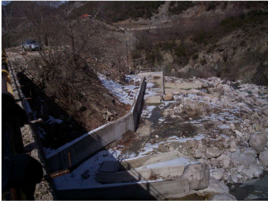
Εικόνα 3.1 Κύρια Υδροληψία ΜΥΗΕ Καταρράκτη (πλημμυρική παροχή, οικολογική παροχή, δεξαμενή φόρτισης) (Πηγή: NANKO ΕΝΕΡΓΕΙΑ Ε.Β.Ε.Τ.Ε.)
