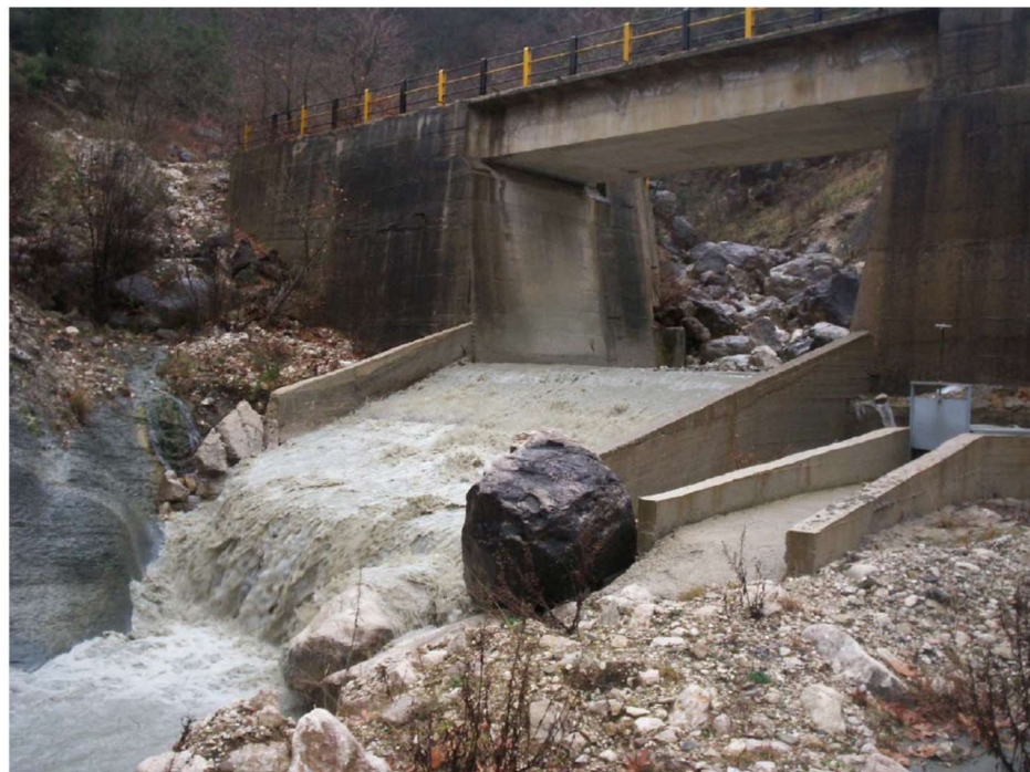
Εικόνα 3.2 Κύρια Υδροληψία ΜΥΗΕ Καταρράκτη (πλημμυρική παροχή, οικολογική παροχή) (Πηγή: NANKO ΕΝΕΡΓΕΙΑ Ε.Β.Ε.Τ.Ε.)
