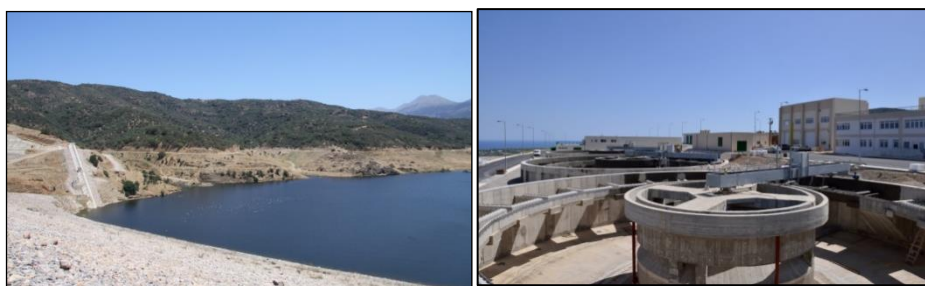
Εικόνα 2-1. Το Φράγμα Αποσελέμη και η Εγκατάσταση Επεξεργασίας Νερού (ΕΕΝ)
