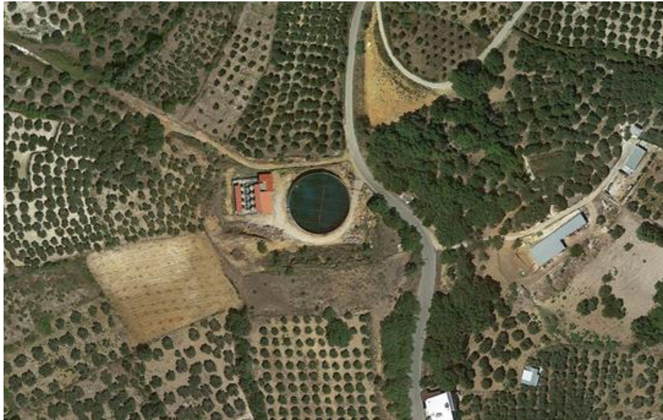
Εικόνα 5-4. Δορυφορική εικόνα αντλιοστασίου που βρίσκεται στα Δράμια
