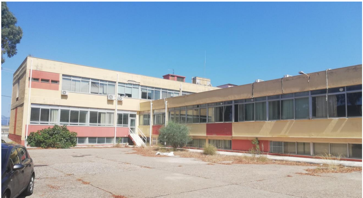
Εικόνα 4: Πλαϊνή όψη του κτιρίου με προσανατολισμό νοτιοδυτικό
