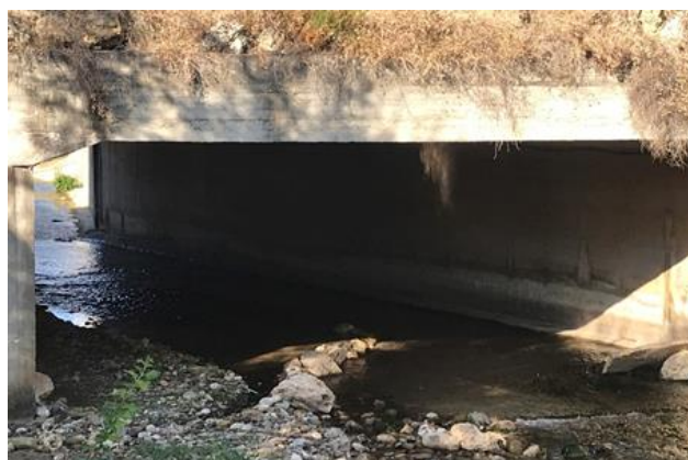
Εικόνα 5.11: Άποψη παραποτάμου Ένωσης α' + β' κατά την δειγματοληψία 2 Σεπτεμβρίου 2018.
