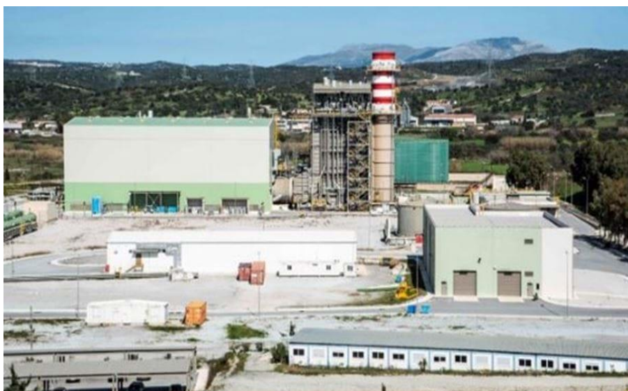
Εικόνα 1.3: Μονάδα Παραγωγής Ηλεκτρικής Ενέργειας Αλιβέρι V [3].
