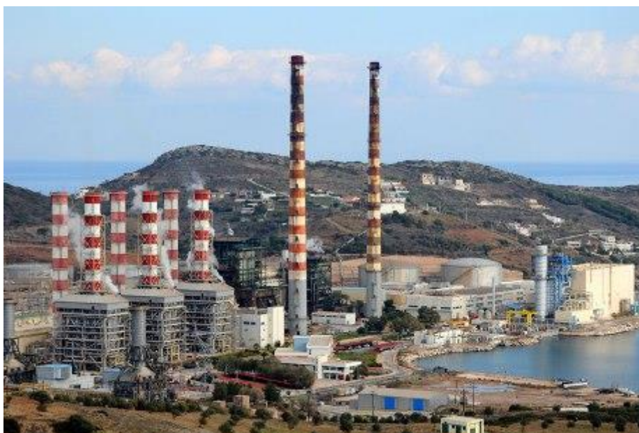
Εικόνα 3.1: Ατμοηλεκτρικός Σταθμός της Δημόσιας Εταιρείας Ηλεκτρισμού Κερατέας-Λαυρίου (ΑΗΣ ΔΕΗ Κερατέας-Λαυρίου).
