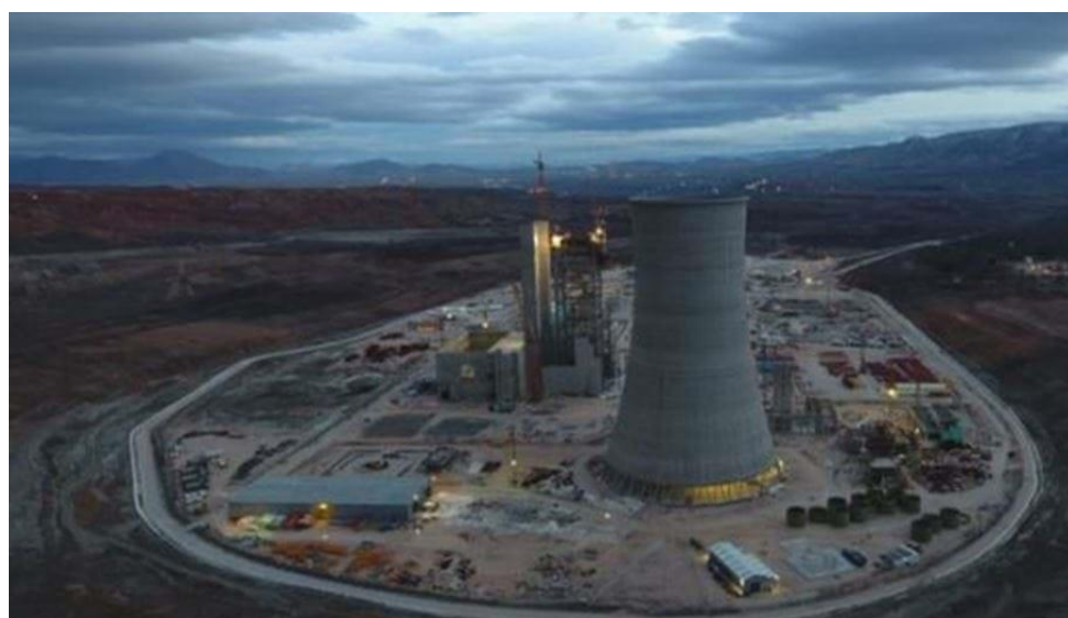
Εικόνα 1.5: Μονάδα Παραγωγής Ηλεκτρικής Ενέργειας Πτολεμαΐδα V [3].
