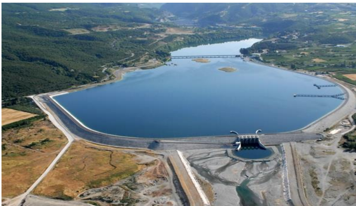
Εικόνα 2.5: Σταθμός Παραγωγής Υδροηλεκτρικής Ενέργειας [7]
