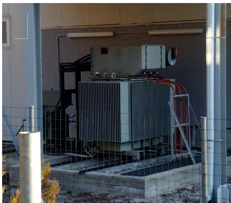
Εικόνα 16: Κύριος Μετασχηματιστής
