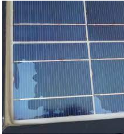
Εικόνα 31 : Απεικόνιση της αποκόλλησης ενός φωτοβολταϊκού κελιού σε μία φωτοβολταϊκή εγκατάσταση.
