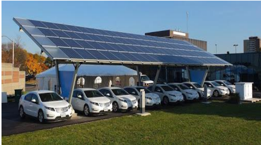
Εικόνα 23 : Υπαίθριος σταθμός φόρτισης ηλεκτρικών οχημάτων.
