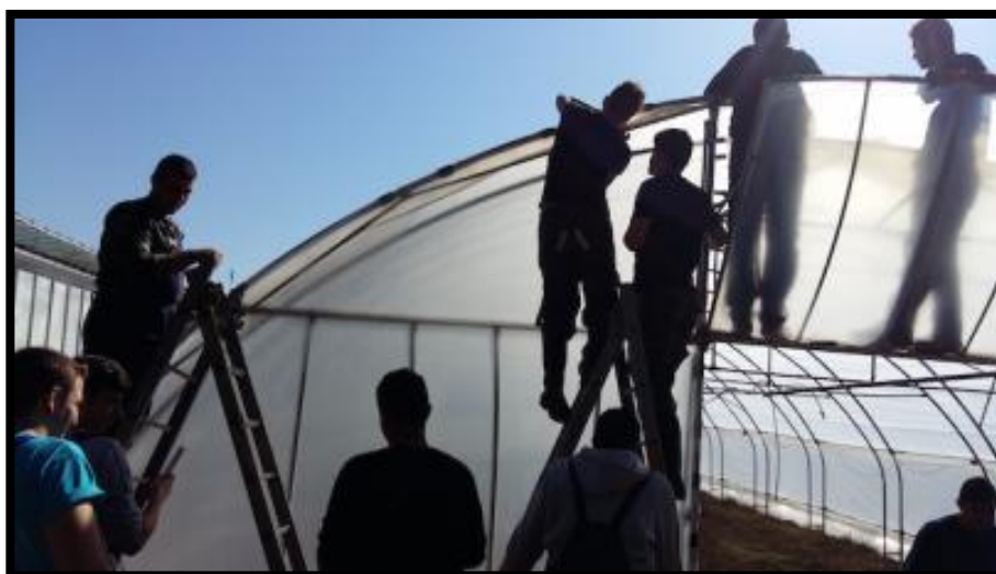
Εικόνα 2.5: Επισκευή σκελετού θερμοκηπίου
