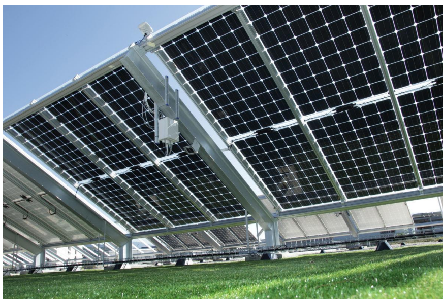
Σχήμα 6.5: Η πίσω όψη των Bifacial φωτοβολταϊκών πλαισίων
