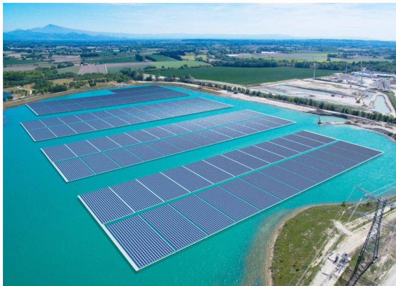
Σχήμα 7.2: Πλωτό διασυνδεδεμένο φωτοβολταϊκό σύστημα κεντρικού σταθμού
