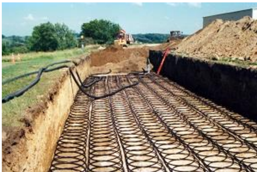
Εικόνα 2. Κλειστό γεωθερμικό σύστημα
