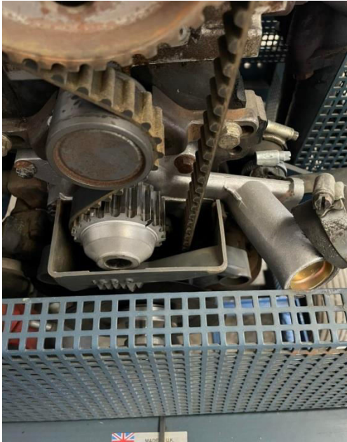
Εικόνα 44 Η τοποθετημένη καινούργια αντλία νερού.
