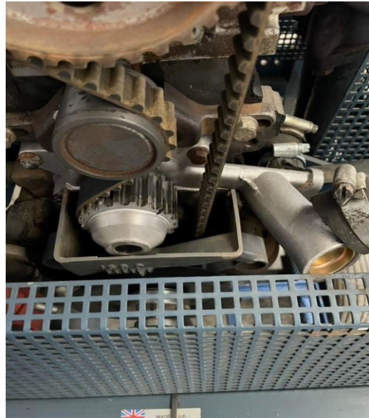
Εικόνα 50 Στη φωτογραφία απεικονίζεται στη κάτω μεριά η κανούργια τρόμπα νερού συνδεδεμένη με τον ιμάντα χρονισμού και από πάνω της ο τεντωτήρας του ιμάντα χρονισμού ο οποίος έχει φέρει τον ιμάντα στο σωστό τέντωμα λειτουργίας του.
