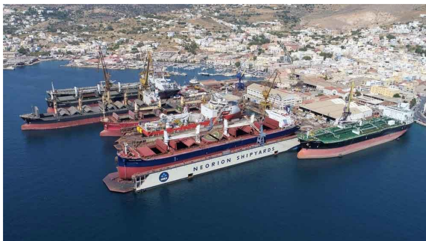
Εικόνα 3.1: Ναυπηγοεπισκευαστική ζώνη Νεωρίου Σύρου
