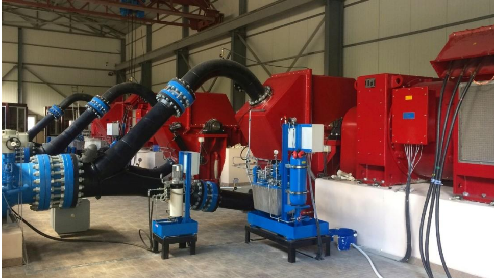
Εικόνα 4.8: Υδροστρόβιλοι Pelton οριζόντιου άξονα από την CINK HYDRO-ENERGY
