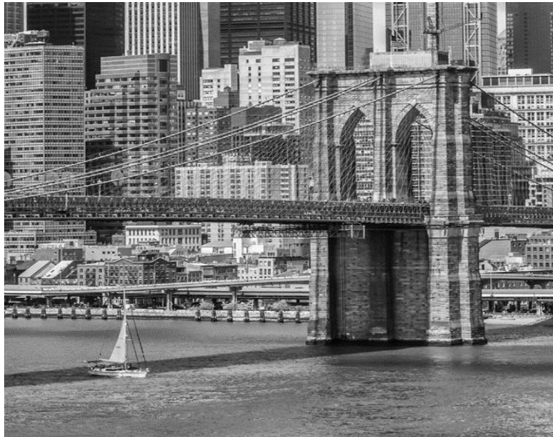
Σχήμα 4.2: Γέφυρα του Brooklyn στην Νέα Υόρκη, κατασκευασμένη το 1833 στον ποταμό East River.
