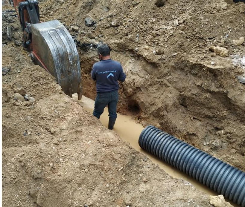
Εικόνα 1.3: Τοποθέτηση αγωγού – Διακρίνεται ο κουβάς του σκαπτικού μηχανήματος πλησίον του εργαζομένου.
