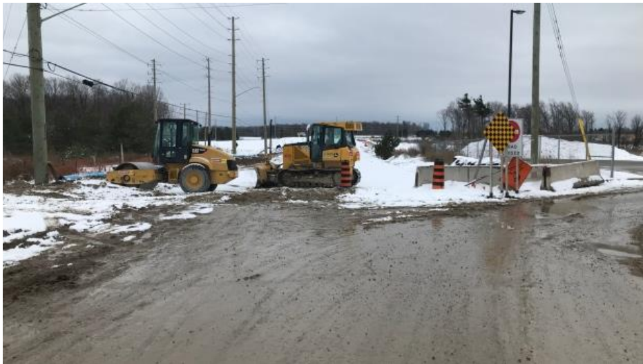
Εικόνα 1.7: Παύση εργασιών σε εργοτάξιο οδοποιίας λόγω καιρικών συνθηκών.
