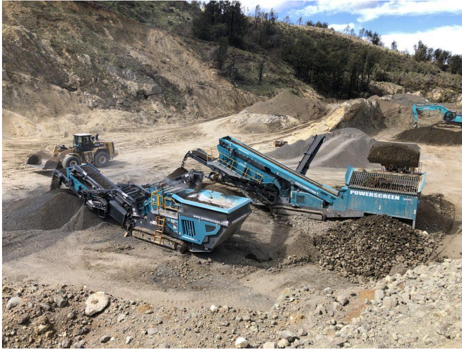
Εικόνα 1.4: Εξοπλισμός παραγωγής αδρανών υλικών
