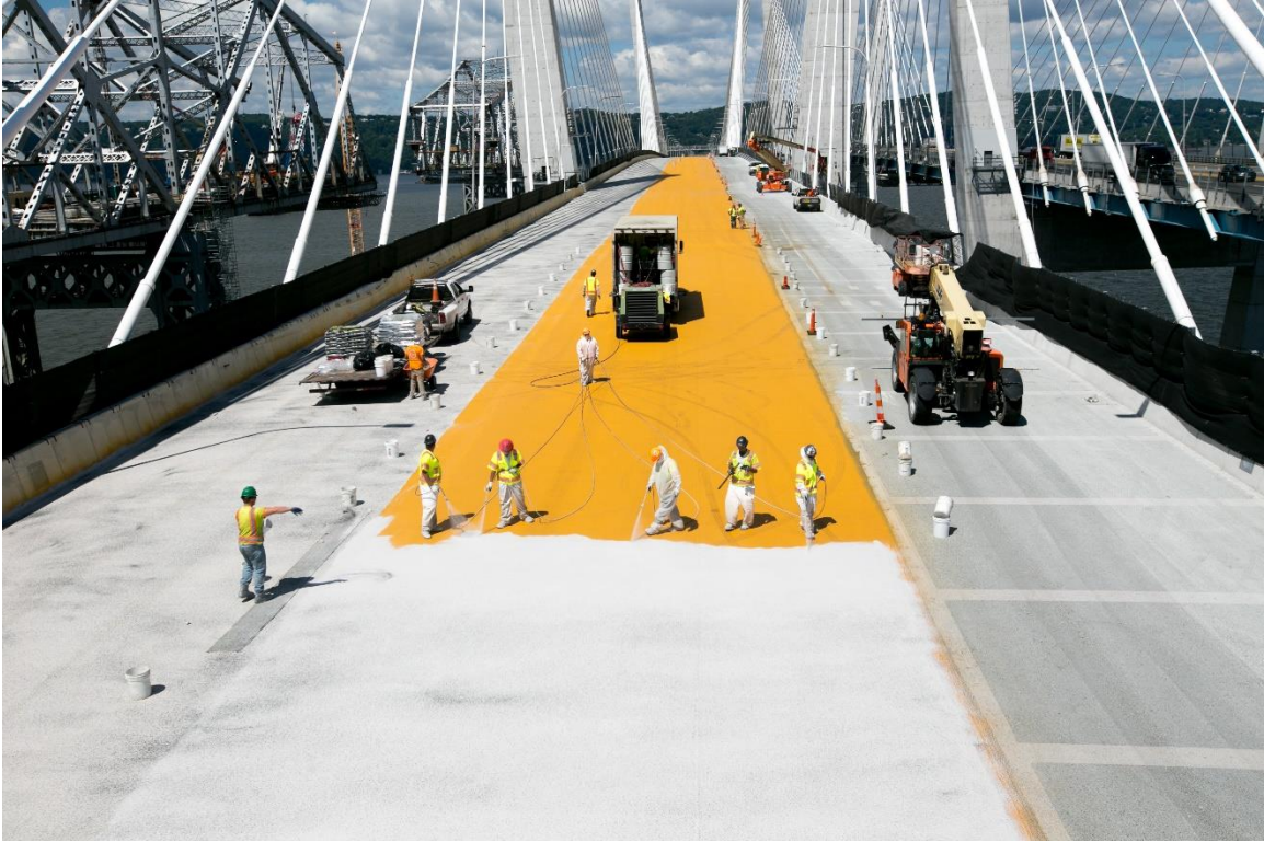
Εικόνα 1.10: Εργασίες στρώσης στεγανοποιητικού υλικού σε γέφυρα.
