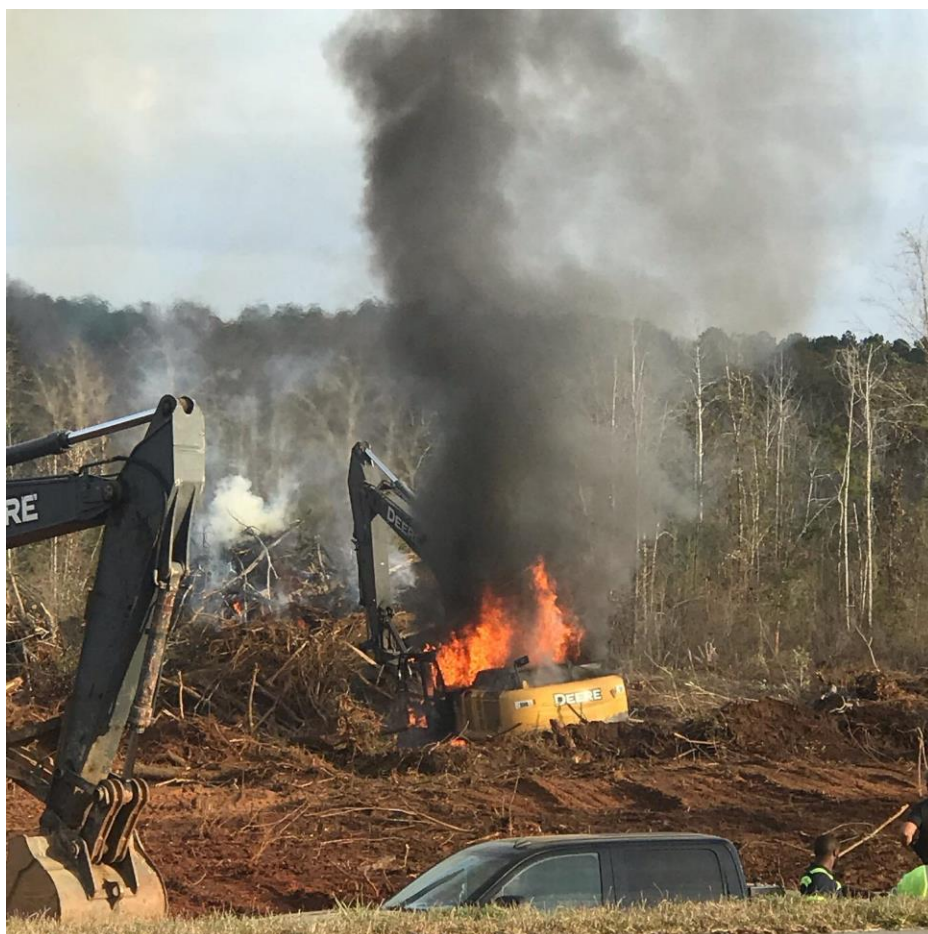
Εικόνα 2.9: Εκσκαφέας τυλίγεται σε φλόγες λόγω βλάβης κοντά σε δασική περιοχή.
