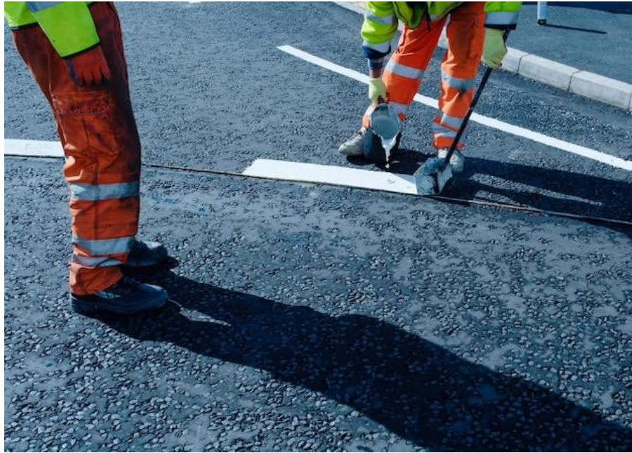
Εικόνα 1.11: Εργασίες διαγράμμισης ασφαλτόστρωσης με θερμοπλαστικό χρώμα και εργαλεία χειρός.
