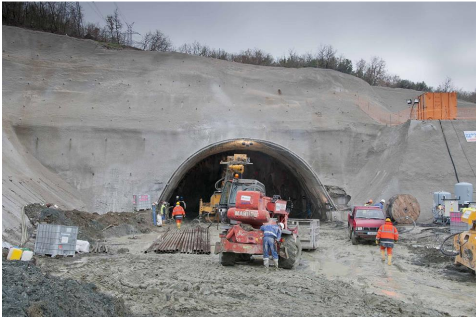
Εικόνα 2.6: Διάνοιξη σήραγγας, διακρίνονται τα ανυψωτικά μηχανήματα που εκτελούν τις πρώτες εργασίες.
