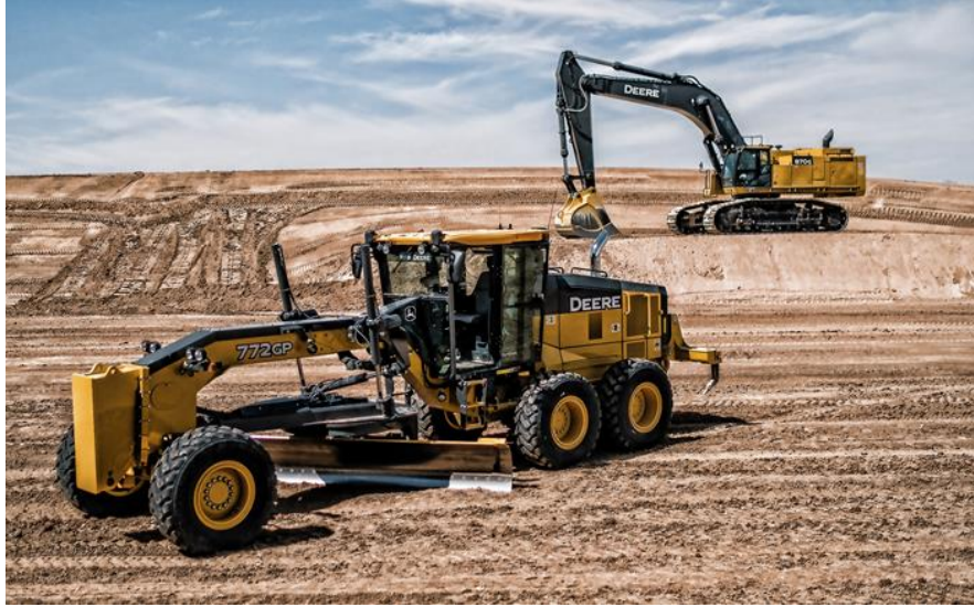
Εικόνα 1.2: Χωματουργικές εργασίες με ισοπεδωτή γαιών (γκρέιντερ) και εκσκαφέα.
