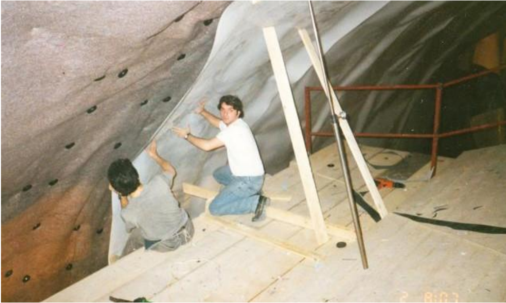
Εικόνα 1.5: Μόνωση σήραγγας με μονωτική γεωμεμβράνη.
