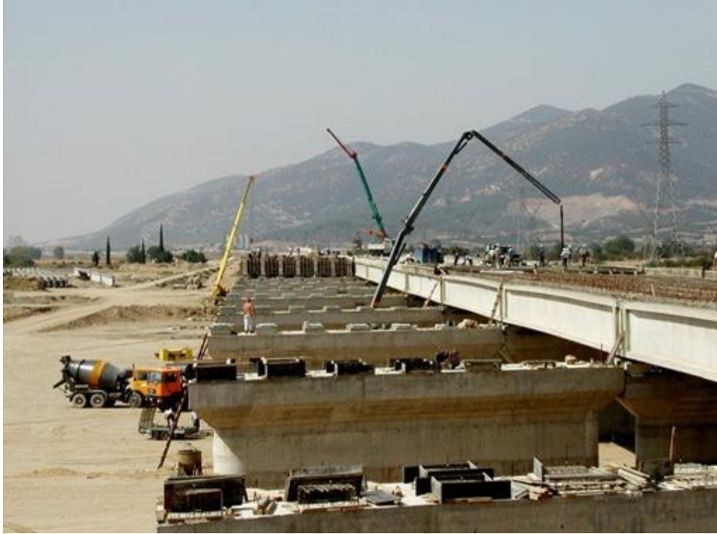
Εικόνα 1.7: Εργασίες σκυροδέτησης γέφυρας εθνικής οδού. Διακρίνονται οι μπετονιέρες καθώς και οι πρέσες σκυροδέματος.
