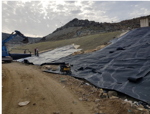
Εικόνα 4.3 Χρήση μεμβράνης για επικάλυψη ΧΥΤΑ
