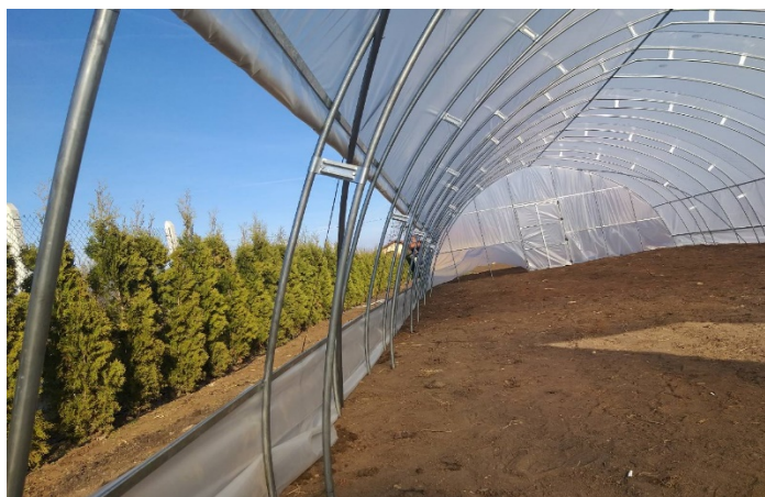
Εικόνα 3.8 Θερμοκήπιο με σκελετό γαλβανισμένου χάλυβα
