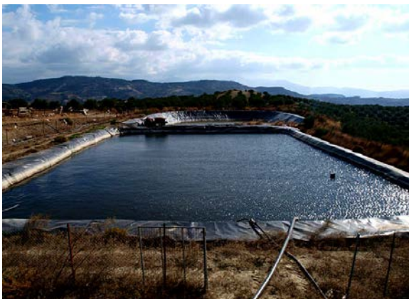
Εικόνα 4.1 Ταμιευτήρας νερού από γεωμεμβράνη Λιμνοδεξαμενή Σκαλοχωρίου - WWF Ελλάς/Κ. Παραγκαμιάν
