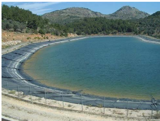
Εικόνα 2.12 Λιμνοδεξαμενή της Χρυσοσκαλίτισσας στην Κίσαμο
