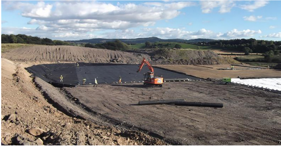
Εικόνα 4.2 Εγκατάσταση γεωμεμβράνης σε ΧΥΤΑ
