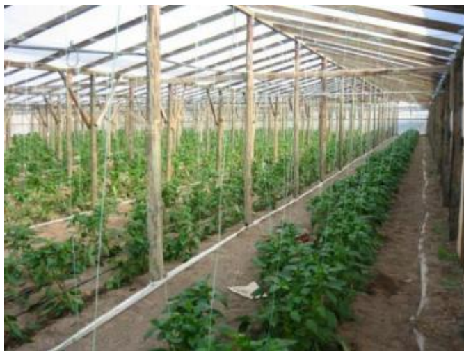
Εικόνα 3.7 Θερμοκήπιο με ξύλινο σκελετό
