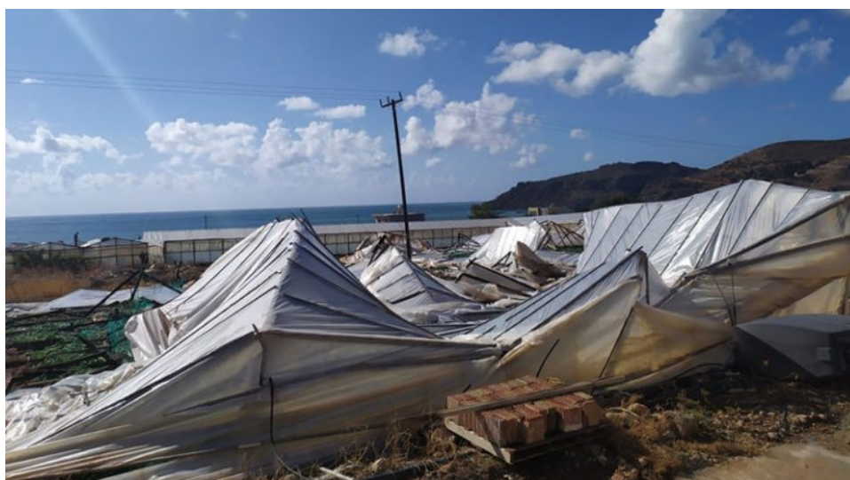
Εικόνα 5.5 Καταστροφή θερμοκηπίων Χανιά 2019
