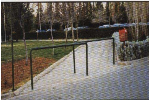
Μπάρες κατά πλάτος του διαδρόμου
