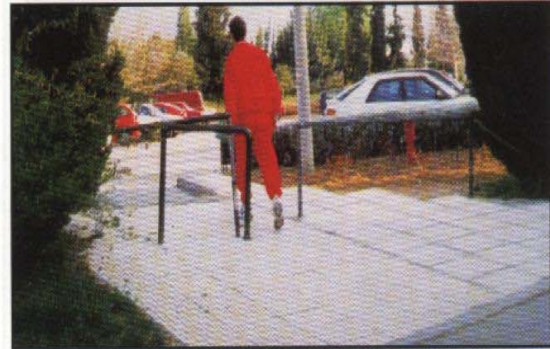
Μπάρες κατά πλάτος του διαδρόμου
