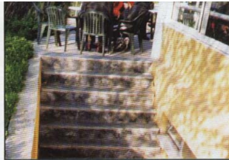
Εξωτερικό κλιμακοστάσιο στο αναψυκτήριο
