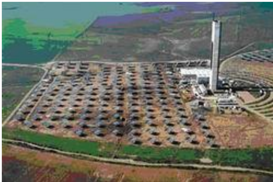
Εικόνα 3-9 Στη Σεβίλλη η πρώτη Φ/Β μονάδα με 624 κινούμενα κάτοπτρα επιφάνειας 121m 2 σε 700 στρέμματα ( http://ecology-salonika.org/2009/?p=368 , 19-09-2010)
