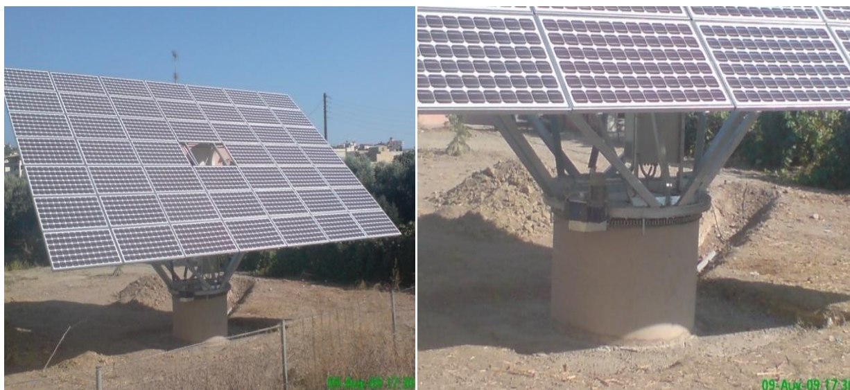
Εικόνα 2-55 Σύστημα παρακολούθησης τροχιάς ήλιου με συγκεντρωτικά Φ/Β πλαίσια (Ηράκλειο 09 Αυγούστου 2009)
