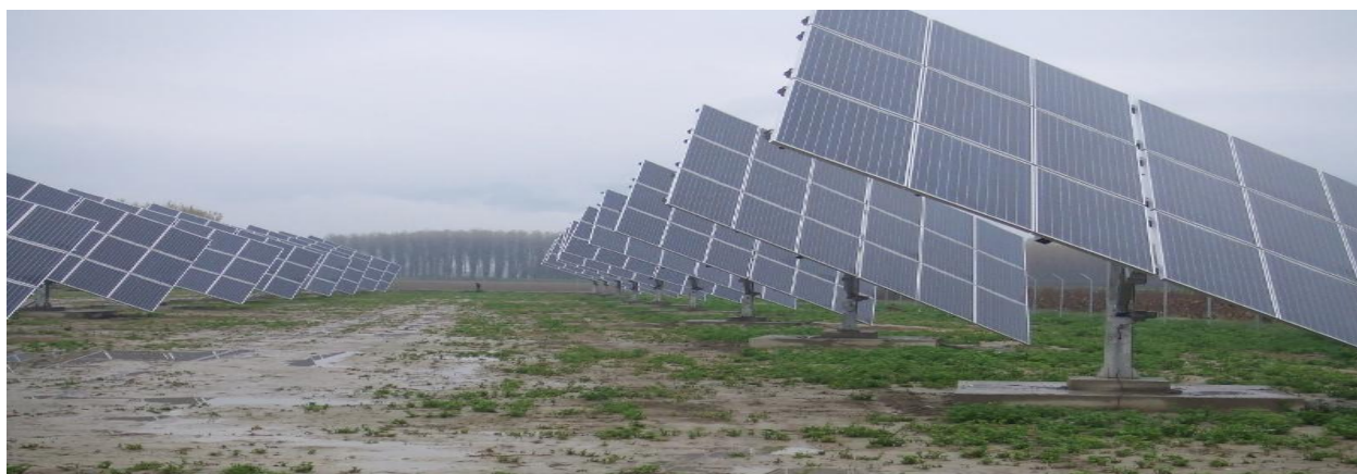
Εικόνα 2-53 Φ/Β Πάρκο με συστήματα κινητής βάσης (Ηλιοστάτες)
