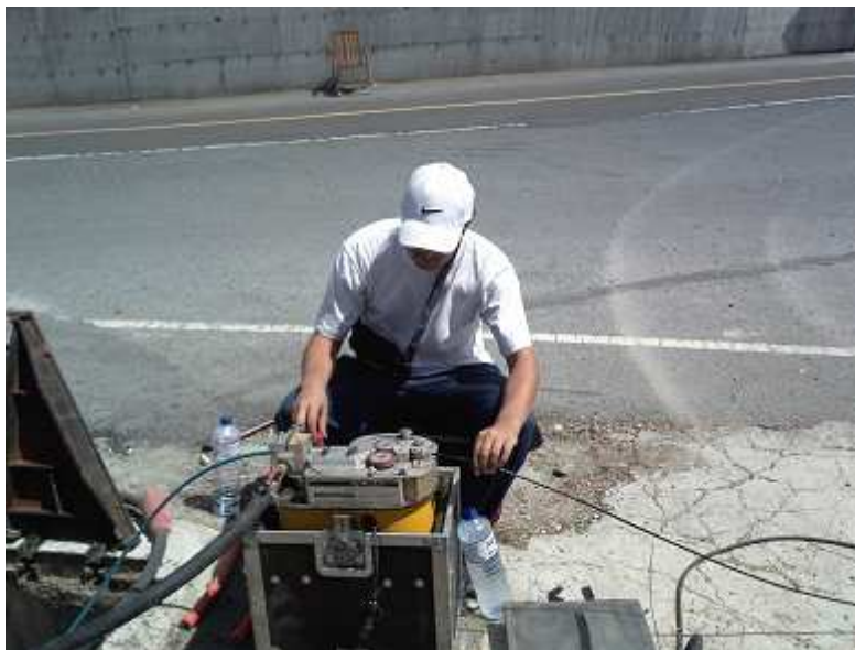
Σχήμα 3.22 : Χρήση του breeze κατά τη διάρκεια φύσηματος καλωδίου.
