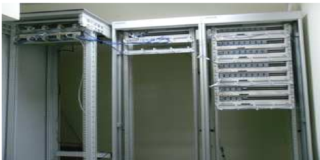
Σχήμα 2.16 : Φωτογραφία που απεικονίζει ένα κύριο κόμβο
