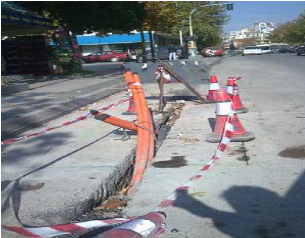
Σχήμα 2.11 : Απεικόνιση φωτογραφίας με σωληνώσεις μέσα σε χάνδακα
