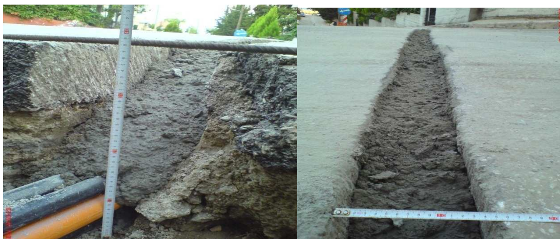
Σχήμα 2.4 : Φωτογραφία χάνδακα τύπου X1.
