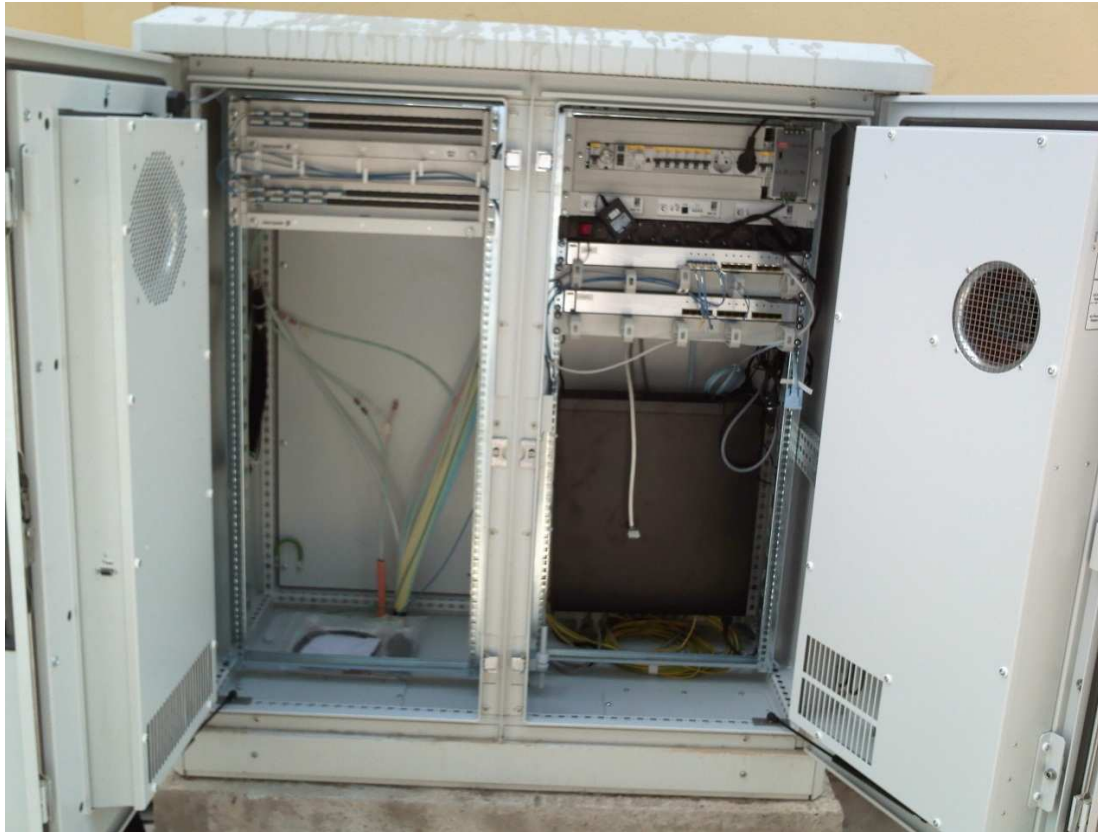
Σχήμα 2.18 : Φωτογραφία που απεικονίζει ένα κόμβο πρόσβασης
