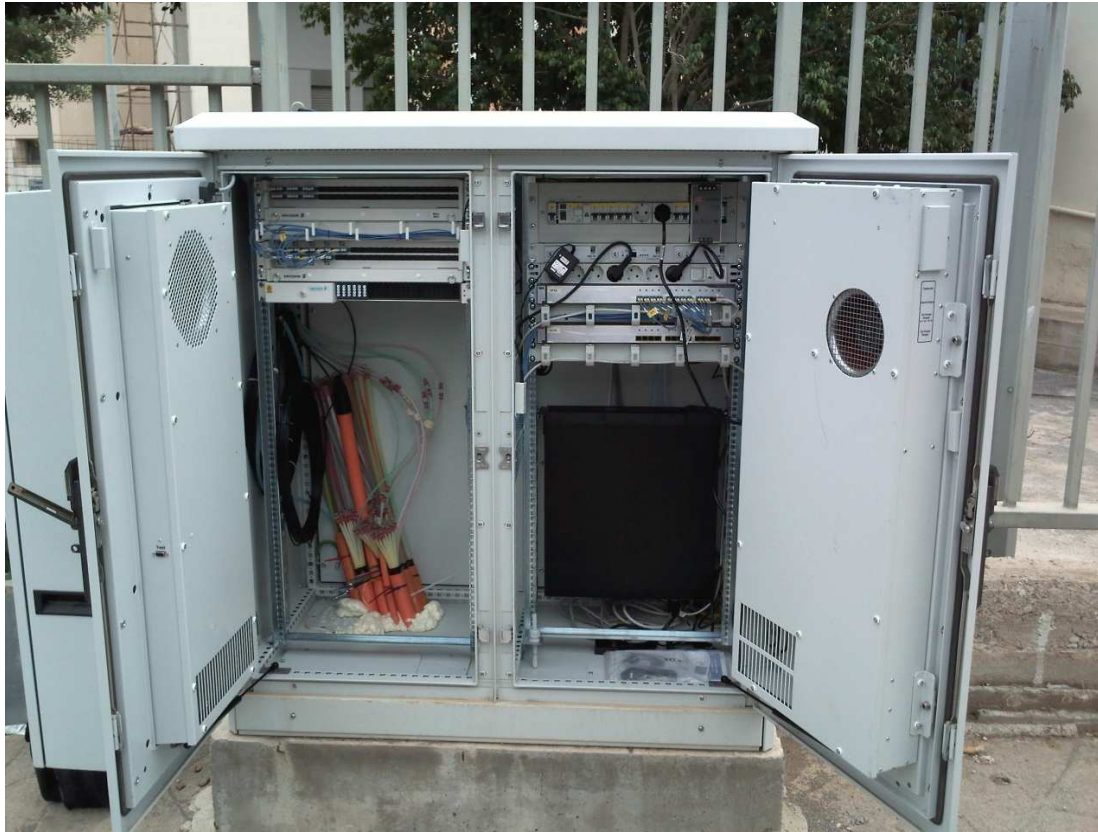
Σχήμα 2.17 : Φωτογραφία που απεικονίζει ένα κόμβο διανομής
