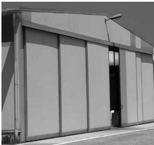
Σχήμα 3.11. Μεταλλικός τοίχος
