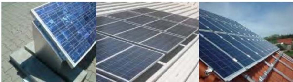
Εικόνα 30. Τύποι βάσεων στήριξης.
