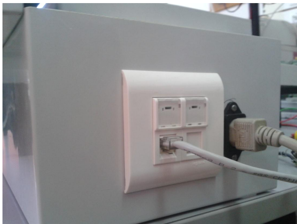
Βύσμα Τροφοδοσίας Κεντρικής Μονάδας και Πρίζα RJ-45 του Δικτύου CAN
