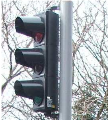
Εικόνα 1.8: Στερέωση με απλό βραχίονα.
