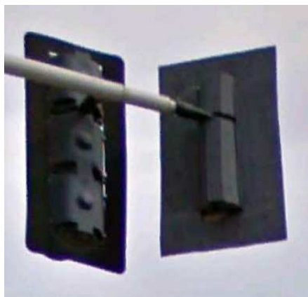
Εικόνα 1.10: Στερέωση πάνω σε οριζόντιο άξονα.
