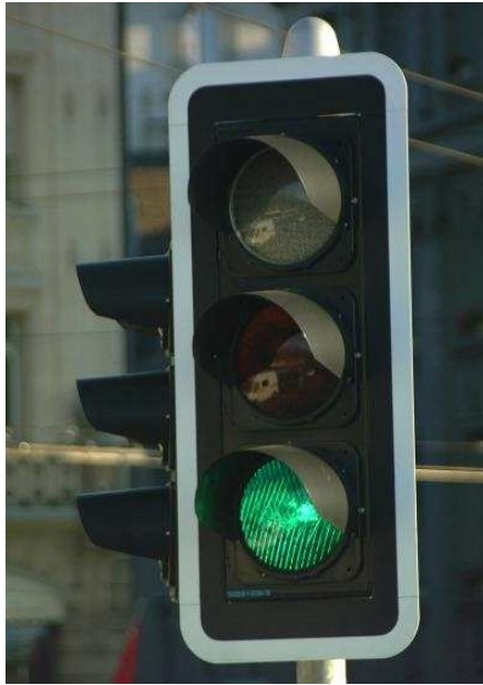
Εικόνα 1.11: Φωτεινός σηματοδότης όπου διακρίνεται το λευκό πλαίσιο αντίθεσης και το σκιάδιο.
