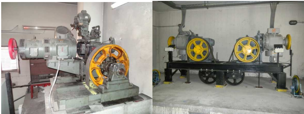
Σχήμα 1.9 Τροχαλία Τριβής
