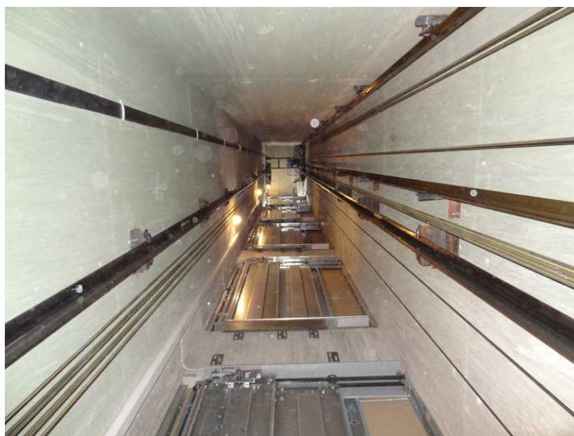
Σχήμα 1.4 Φρεάτιο ηλεκτροκίνητου ανελκυστήρα έλξεως
