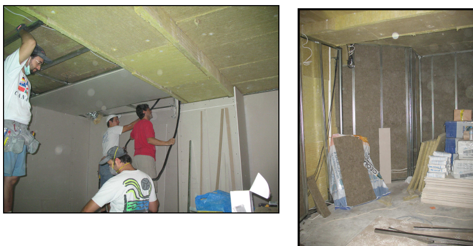
Εικόνα 4.20 Εφαρμογή πετροβάμβακα σε ταβάνι studio ηχογραφήσεων (σύστημα ανάρτησης οροφής γυψοσανίδας).
