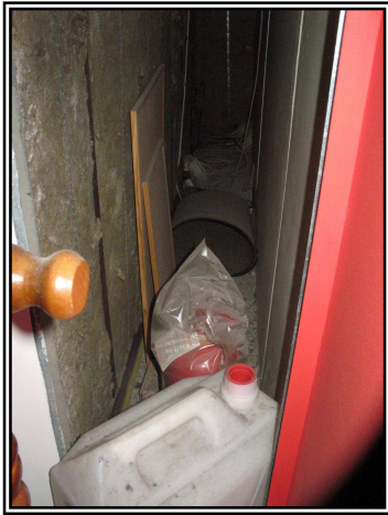
Εικόνα 6.12 Κενό μεταξύ της τοιχοποιίας Δ και Δ1 του control room.
