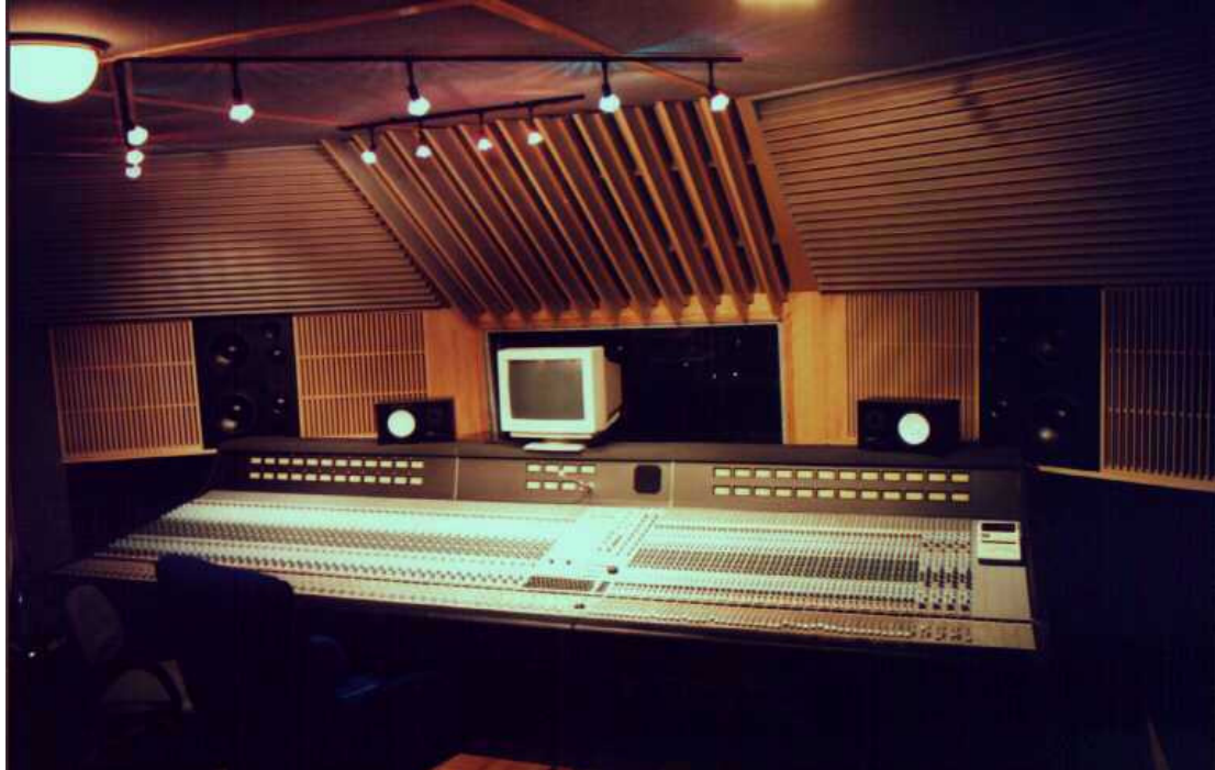
Σχήμα 2. Control Room με προδιαγραφές ESS
