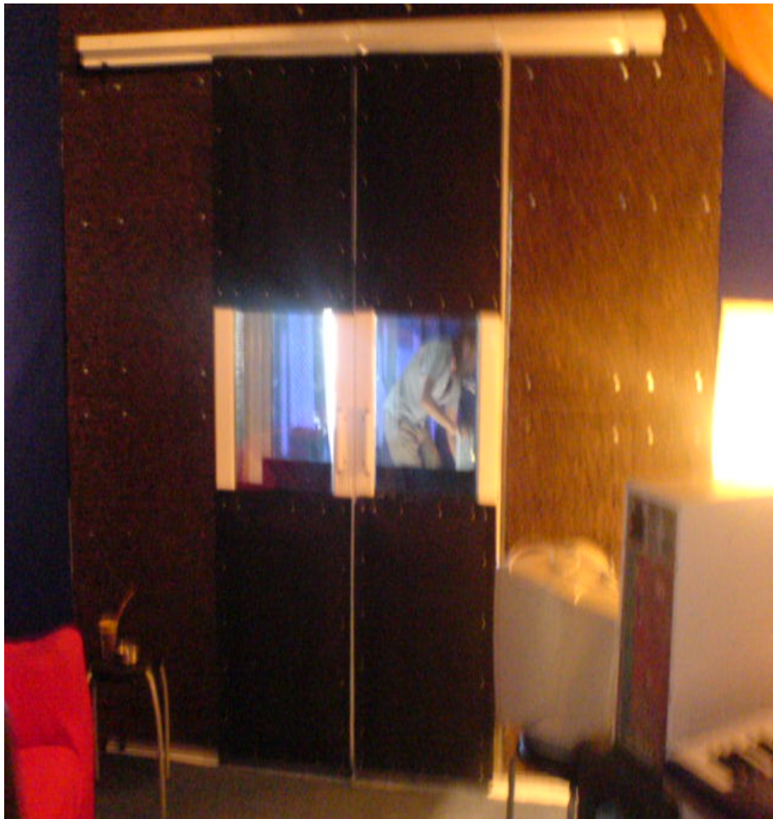
Σχήμα 3. Ο αριστερός τοίχος, ο οποίος έχει μία διπλή συρόμενη πόρτα, με απλό μονό τζάμι, το οποίο όπως βλέπουμε, είναι καλυμμένο πάνω και κάτω μερικώς, με απλή μοκέτα, ενώ ο υπόλοιπος τοίχος είναι καλυμμένος με φελλό.
