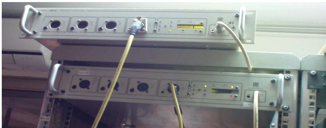
Σχ.13) Οι 2 πομποί που στέλνουν το σήμα στις κεραίες 1) Κορομηλιά - Καλαμπάκας και 2) Δοβρούτσι – Τρικάλων βρίσκονται επίσης στο χώρο του control room
