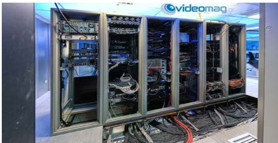
Σχ.21) Οι καλωδιώσεις πάνω και κάτω από το πάτωμα., από εκεί προέρχεται και η ψύξη του δωματίου.
