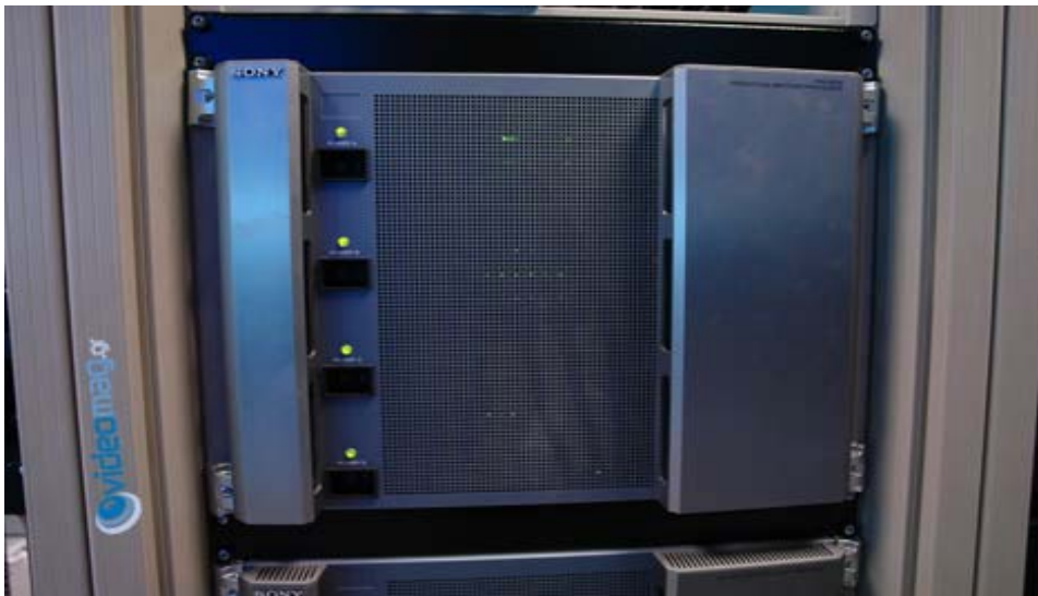
Σχ.19) Το hardware της DVS9000 της Sony. Εκεί συνδέονται οι δύο controller που βρίσκονται εγκατεστημένοι στα δύο control room που βρίσκονται δίπλα δίπλα.
