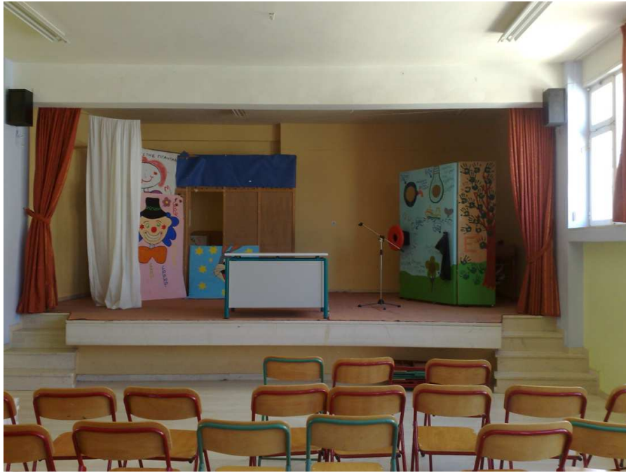
Σχήμα 7.4.1. Η σκηνή, όπου θα τοποθετηθούν οι γυψοσανίδες.
