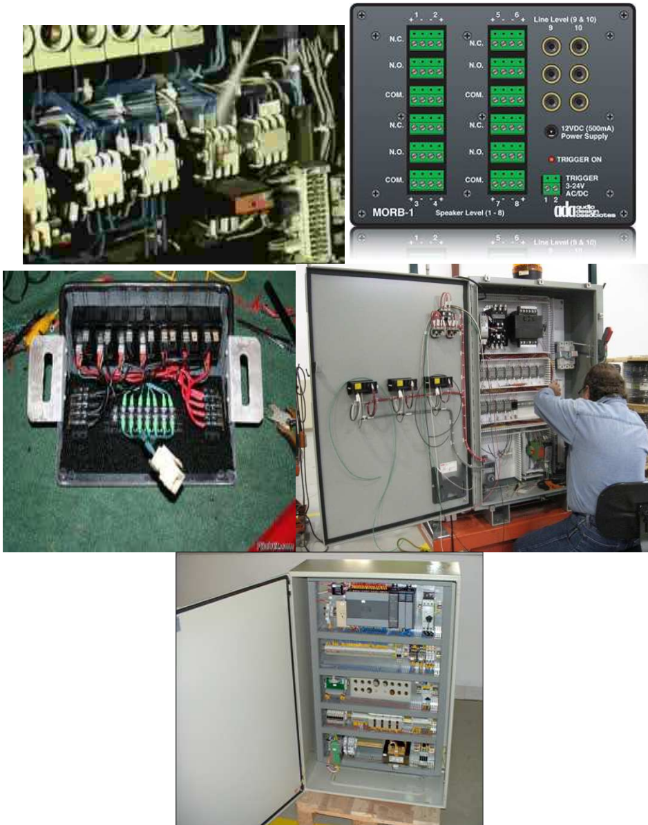
Σχήμα 3.14: Παραδείγματα πινάκων ελέγχου ισχύος. Διακρίνουμε ομοίως με του πίνακες σημάτων από απλές μορφές μικρών απαιτήσεων μέχρι πιο πολύπλοκες συνθέσεις.
