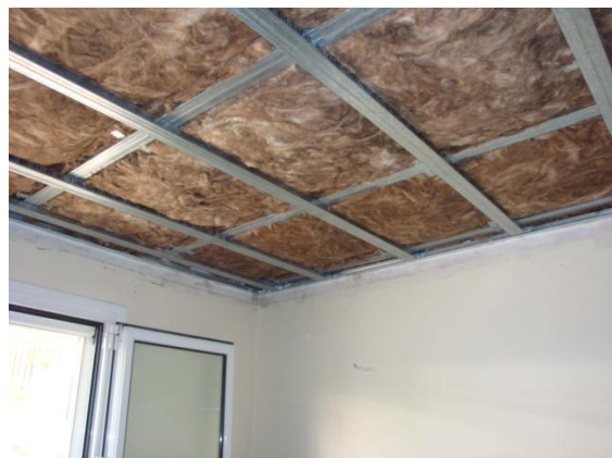
Εικόνα 17. Προσθήκη ορυκτοβάμβακα στο μεταλλικό σκελετό της οροφής.
