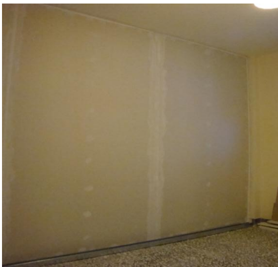
Εικόνα 7. Τελευταία στρώση γυψοσανίδας με αρμολόγηση στην πλευρά του τοίχου με μήκος 3.67m.
