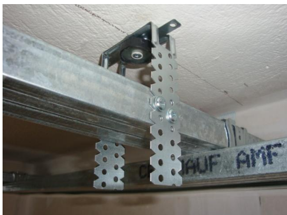
Εικόνα 15. Άμεση αντικραδαστική ανάρτηση «Π» και συνδετήρας «Π».
