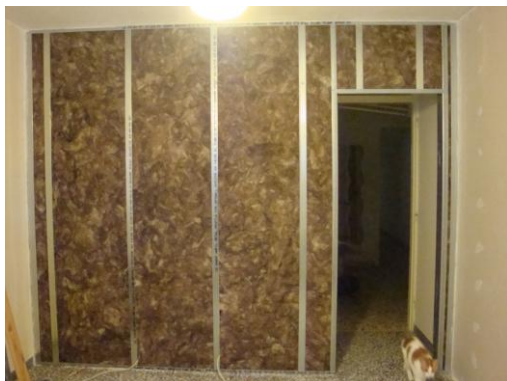
Εικόνα 12. Προσθήκη ορυκτοβάμβακα στο μεταλλικό σκελετό της πλευράς του τοίχου με μήκος 2.155m. Προσθήκη ορυκτοβάμβακα σε κάθε πλευρά του διπλού μεταλλικού σκελετού, στο υπέρθυρο και περιμετρικά του ανοίγματος της πόρτας.
