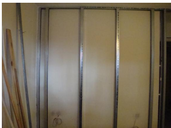
Εικόνα 9. Μεταλλικός σκελετός στην πλευρά του τοίχου με μήκος 2.155m.
