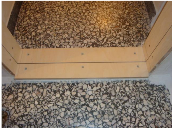
Εικόνα 22. Στην ένωση του δαπέδου με το κατωκάσι τοποθετείται επίσης πεπιεσμένος ορυκτοβάμβακας και ο αρμός ένωσης σφραγίζεται με ελαστικό στόκο και από τις δύο πλευρές.
