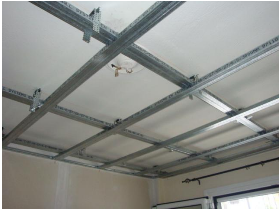
Εικόνα 16. Μεταλλικός σκελετός αναρτημένος στην οροφή.
