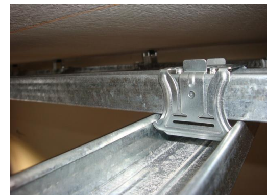
Εικόνα 15. Άμεση αντικραδαστική ανάρτηση «Π» και συνδετήρας «Π».
