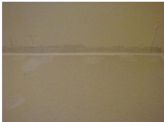
Εικόνα 7. Τελευταία στρώση γυψοσανίδας με αρμολόγηση στην πλευρά του τοίχου με μήκος 3.67m.
