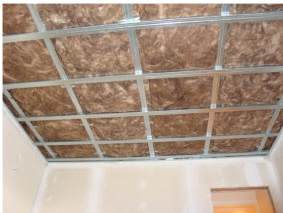
Εικόνα 17. Προσθήκη ορυκτοβάμβακα στο μεταλλικό σκελετό της οροφής.
