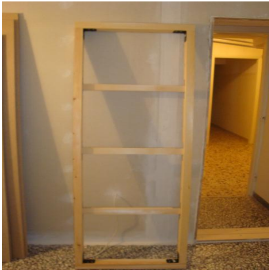
Εικόνα 23. Το τελάρο της πόρτας και οι μοριοσανίδες που χρησιμοποιούνται για το κέλυφος της πόρτας. Δύο μοριοσανίδες πάχους 16mm και δύο πάχους 8mm.
