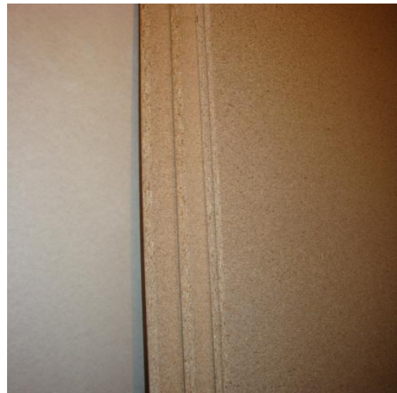
Εικόνα 23. Το τελάρο της πόρτας και οι μοριοσανίδες που χρησιμοποιούνται για το κέλυφος της πόρτας. Δύο μοριοσανίδες πάχους 16mm και δύο πάχους 8mm.
