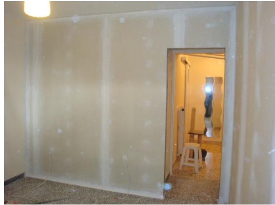
Εικόνα 13. Πρώτη στρώση γυψοσανίδας στην πλευρά του τοίχου με μήκος 2.155m και σε κάθε πλευρά περιμετρικά του ανοίγματος της πόρτας. Οι αρμοί στο υπέρθυρο δεν είναι ο ένας πίσω από τον άλλο.
