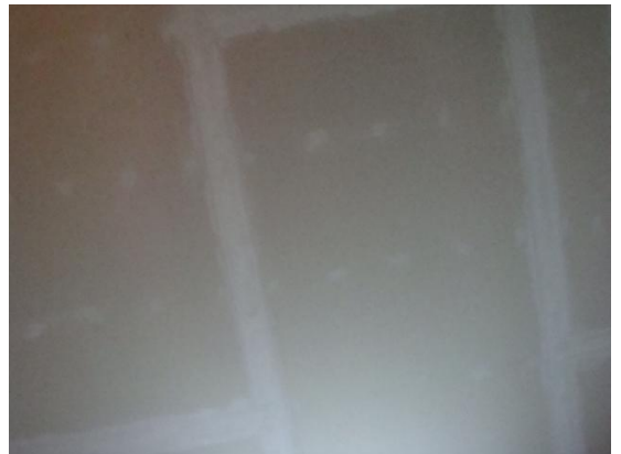
Εικόνα 18. Πρώτη και δεύτερη στρώση γυψοσανίδας στην οροφή.
