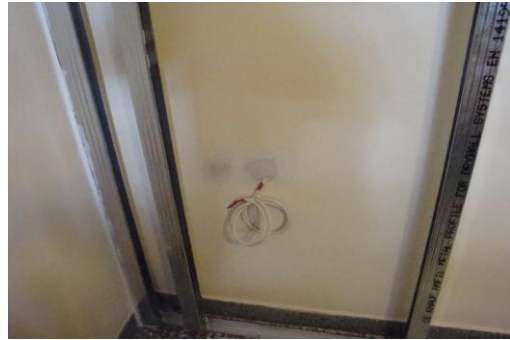
Εικόνα 10. Οι τρύπες στις παροχές ρεύματος έχουν γεμίσει στόκο, για να αποφύγουμε διαρροές του ήχου από εκεί.
