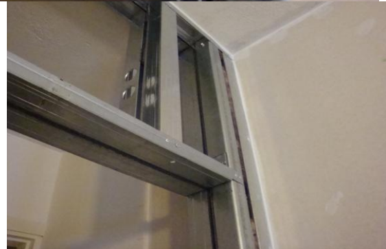
Εικόνα 11. Διπλός μεταλλικός σκελετός περιμετρικά της πόρτας, η επαφή των δύο σκελετών γίνεται με αφρώδη ηχομονωτική ταινία. Στην πλευρά όπου θα στηρίζεται η πόρτα χρησιμοποιούμε UA-προφίλ πάχους 2mm για να αντέξει το βάρος της.
