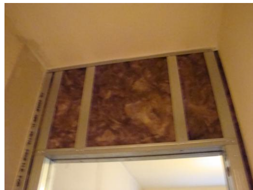
Εικόνα 12. Προσθήκη ορυκτοβάμβακα στο μεταλλικό σκελετό της πλευράς του τοίχου με μήκος 2.155m. Προσθήκη ορυκτοβάμβακα σε κάθε πλευρά του διπλού μεταλλικού σκελετού, στο υπέρθυρο και περιμετρικά του ανοίγματος της πόρτας.
