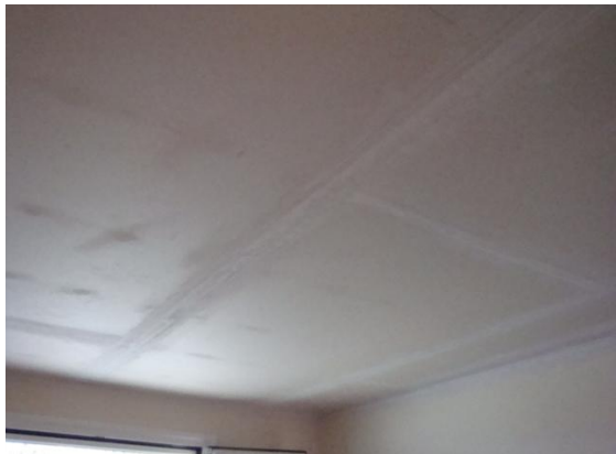
Εικόνα 18. Πρώτη και δεύτερη στρώση γυψοσανίδας στην οροφή.
