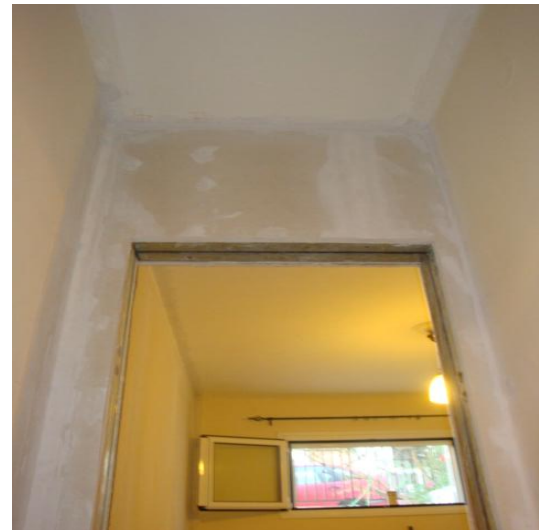
Εικόνα 14. Δεύτερη στρώση γυψοσανίδας στην πλευρά του τοίχου με μήκος 2.155m και σε κάθε πλευρά περιμετρικά του ανοίγματος της πόρτας.
