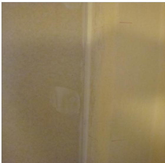
Εικόνα 8. Η ένωση της γυψοσανίδας με το φέροντα οργανισμό γίνεται περιμετρικά με ακρυλική μαστίχη, όπως και ο μεταλλικός σκελετός.
