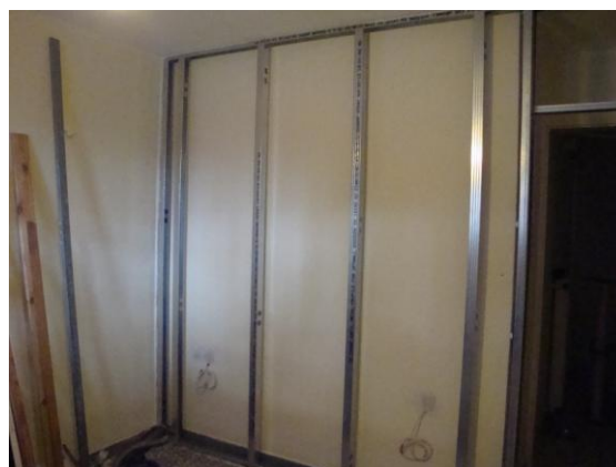
Εικόνα 9. Μεταλλικός σκελετός στην πλευρά του τοίχου με μήκος 2.155m.
