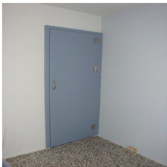
Εικόνα 24. Ολοκληρωμένη κατασκευή κάσας και πόρτας. Η πόρτα σφραγίζει περιμετρικά σε δύο επίπεδα, στην επαφή της με την κάσα παρεμβάλλεται λάστιχο. Η πόρτα στηρίζεται στην κάσα με τρεις μεντεσέδες υψηλής αντοχής.
