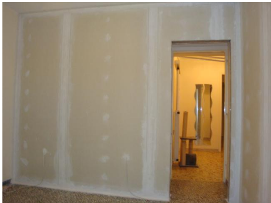
Εικόνα 13. Πρώτη στρώση γυψοσανίδας στην πλευρά του τοίχου με μήκος 2.155m και σε κάθε πλευρά περιμετρικά του ανοίγματος της πόρτας. Οι αρμοί στο υπέρθυρο δεν είναι ο ένας πίσω από τον άλλο.
