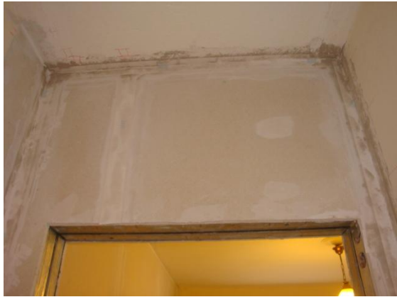
Εικόνα 13. Πρώτη στρώση γυψοσανίδας στην πλευρά του τοίχου με μήκος 2.155m και σε κάθε πλευρά περιμετρικά του ανοίγματος της πόρτας. Οι αρμοί στο υπέρθυρο δεν είναι ο ένας πίσω από τον άλλο.
