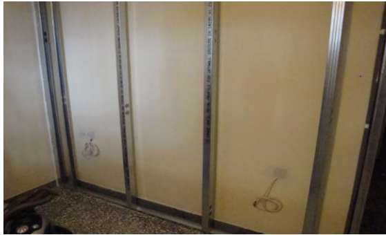
Εικόνα 10. Οι τρύπες στις παροχές ρεύματος έχουν γεμίσει στόκο, για να αποφύγουμε διαρροές του ήχου από εκεί.
