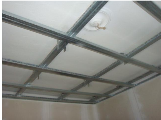
Εικόνα 16. Μεταλλικός σκελετός αναρτημένος στην οροφή.
