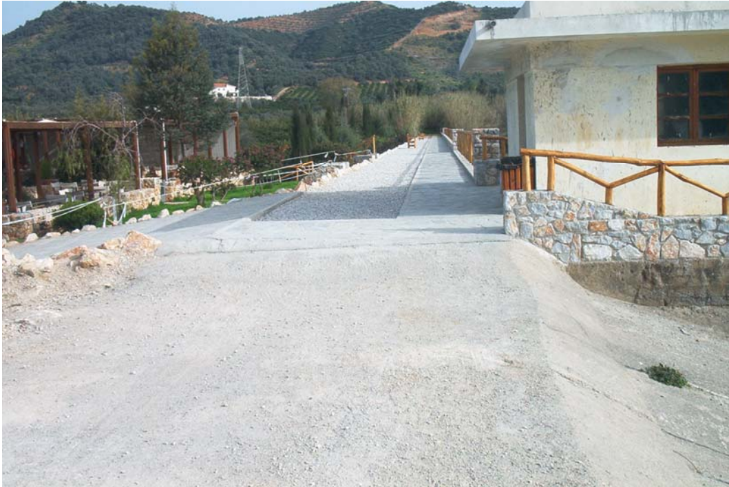
Σχήμα 3.19 Θέση εκτέλεσης της γεωηλεκτρικής διασκόπησης στη στέψη του φράγματος από τα 0.00 έως τα 115.00 μέτρα.
