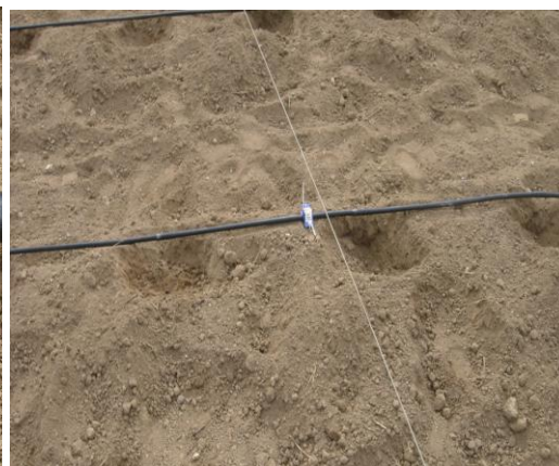
Εικόνα 4: Μαγνήτης τοποθετημένος στη μέση του σωλήνα άρδευσης .
