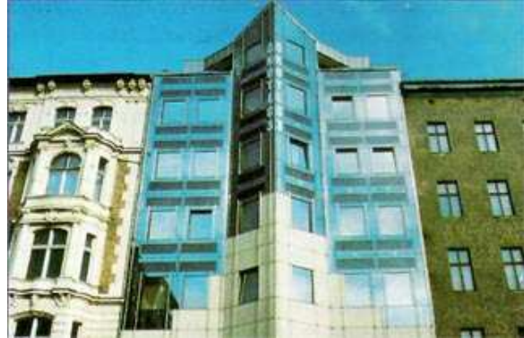
Σχήμα 47 : Φ/Β σε πρόσοψη κτιρίου
