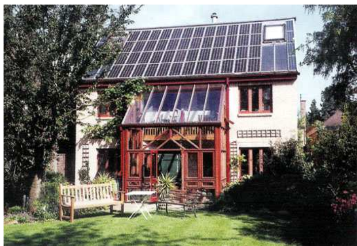
Σχήμα 44 : Σε αυτό το ηλιακό σπίτι στην Οξφόρδη, μία συστοιχία 4 kW p , συνδεδεμένη με το δίκτυο, από Φ/Β πλαίσια μονοκρυσταλλικού πυριτίου σχηματίζουν ένα ενδογενές τμήμα της οροφής, μαζί με ηλιακούς συλλέκτες για θέρμανση νερού.
