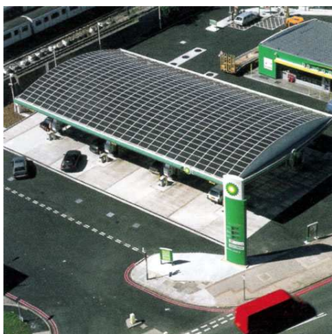
Σχήμα 43 : Η οροφή αυτού του βενζινάδικου στο Λονδίνο έχει μία μεγάλη Φ/Β συστοιχία που προσφέρει αρκετό ηλεκτρισμό για να δουλέψουν τα φώτα και οι αντλίες.
