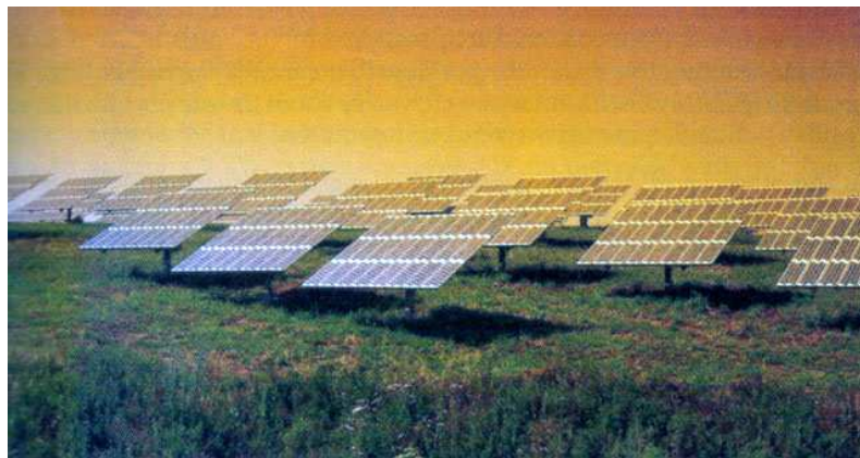
Σχήμα 42 : Το εργοστάσιο παραγωγής ενέργειας ισχύος 340kW στο Kobern-Gondorf, στη Γερμανία μία από τις αρκετές μεγάλες εγκαταστάσεις Φ/Β συνδεδεμένες με το δίκτυο, που διευθύνεται από την εταιρεία ηλεκτρισμού RWE.
