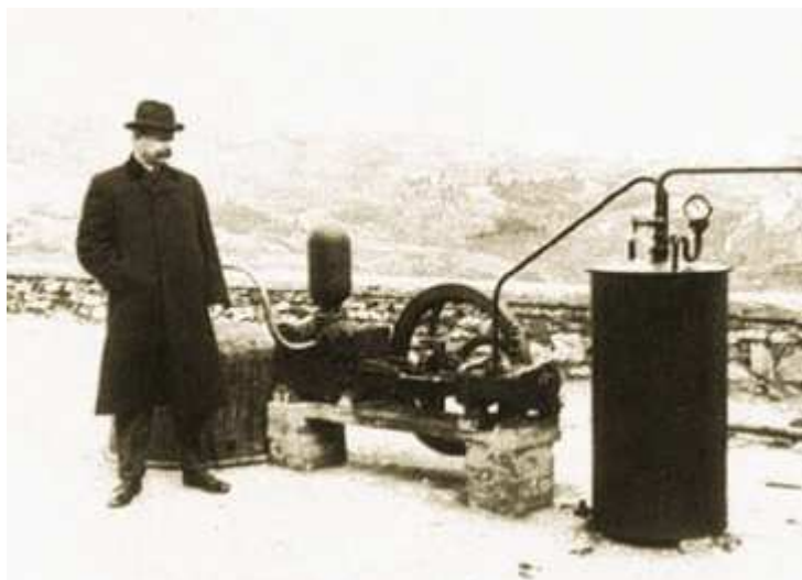
Εικόνα 6.4. Η μηχανή που χρησιμοποιήθηκε στο Larderello το 1904 κατά την πρώτη πειραματική απόπειρα παραγωγής ηλεκτρικής ενέργειας από γεωθερμικό ατμό. Διακρίνεται επίσης ο εφευρέτης της, πρίγκιπας Piero Ginori Conti [17].
