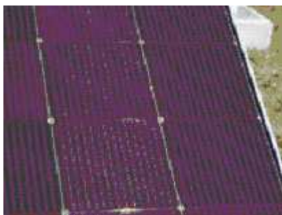
Εικόνα 6.3. Φωτοβολταϊκά στοιχεία αμόρφου πυριτίου [15].
