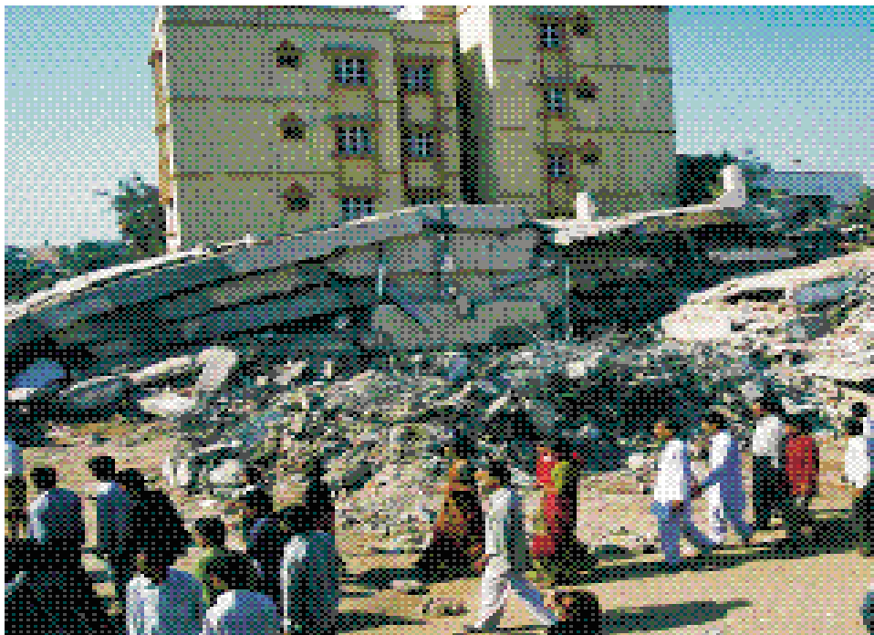
σχ2.2 η κατάρρευση ενός σχολικού κτιρίου που χτίστηκε στην Ινδία στη διάρκεια σεισμού μεγέθους 7.7 το 2001
