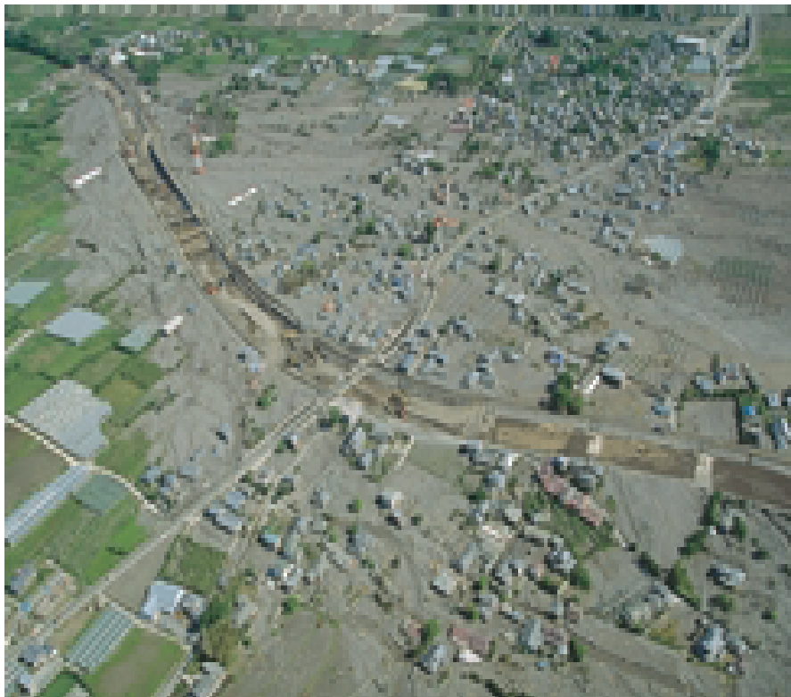
Σχ 3.1 (β) λασποροή κατέκλυσε τα σπίτια και τα κτίρια στο κέντρο της φωτογραφίας
