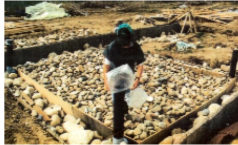
Εικόνα 21 Το κύκλωμα θερμού - ψυχρού αέρα. Εικόνα 22 Κατασκευή Rock Bed μεταξύ θερμοκηπίου και Rock Bed
