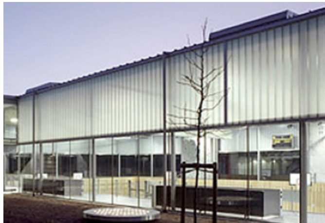
Εικόνα 33 Διαφανή υλικά μόνωσης σε εξωτερικό χώρο
