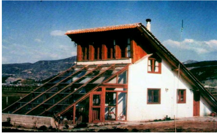
Εικόνα 3 Βιοκλιματικό κτίριο στην Ξάνθη Μελέτη Ε. Γεωργιάδου
