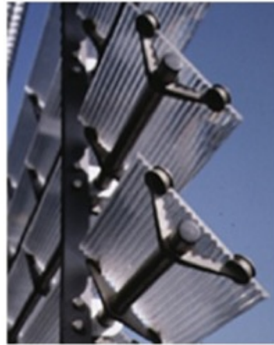
Εικόνα 32 Πρισματικά υλικά που διαθλούν τις ακτίνες φωτός
