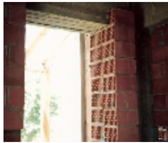
Εικόνα 6 Σύγχρονη κατοικία στο Πανόραμα. Τοίχοι πάχους 46 εκ.
