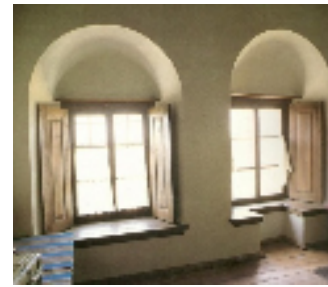
Εικόνα 7 Μακρινίτσα. Το πάχος των τοίχων φαίνεται στα παράθυρα
