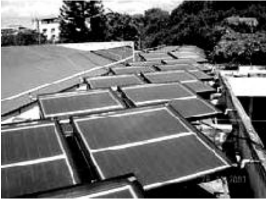
Εικόνα10-11- Εγκαταστάσεις PV/T TFPV στην Ταϊλάνδη
