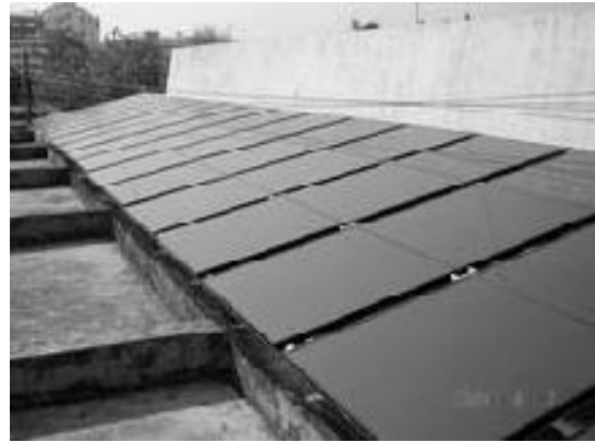
Εικόνα10-11- Εγκαταστάσεις PV/T TFPV στην Ταϊλάνδη
