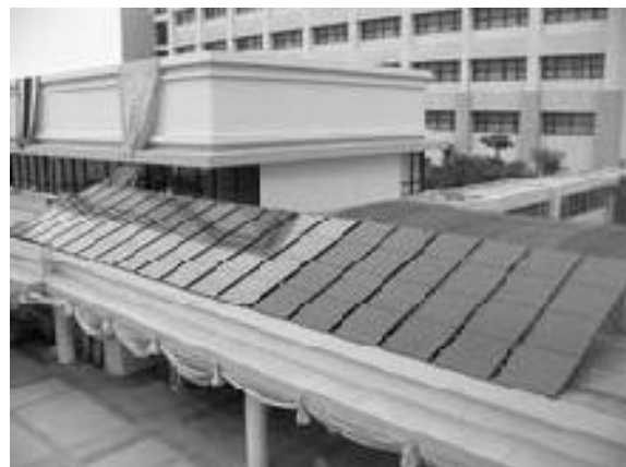
Εικόνα8-9- Εγκαταστάσεις PV/T TFPV στην Ταϊλάνδη
