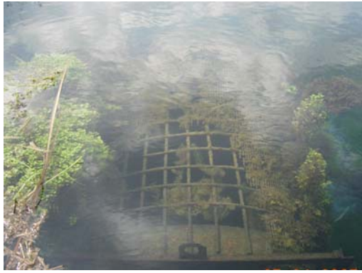
Εικόνα 3.5.7.γ : Πηγή Καλαμιώνας 5/4/2005
