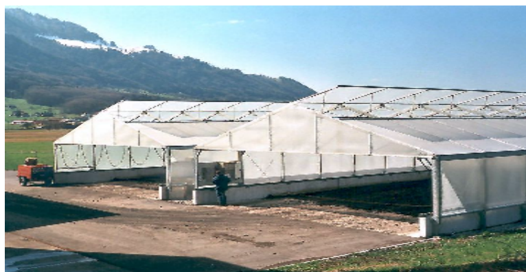
Σχήμα 3.5: Θερμοκήπιο με ρυθμιζόμενη οροφή εξαερισμού
