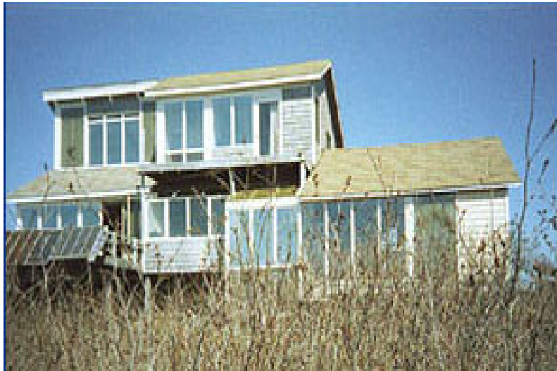
Σχήμα 2.3. Τα μεγάλα παράθυρα και ο νότιος προσανατολισμός του κτηρίου εκμεταλλεύονται καλύτερα την ηλιακή ενέργεια.
