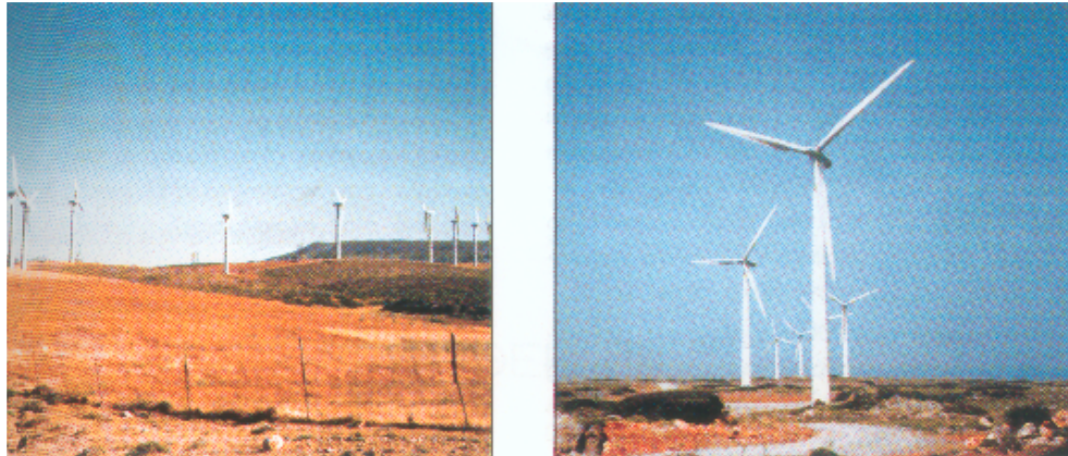
Σχήμα 10.3. Α.Π της ΔΕΗ 6,6MW στη Σητεία και δεξιά Α.Π. της εταιρεία « ΡΟΚΑΣ Αιολική Α.Β.Ε.Ε.», ισχύος 10,2MW στη Σητεία.
