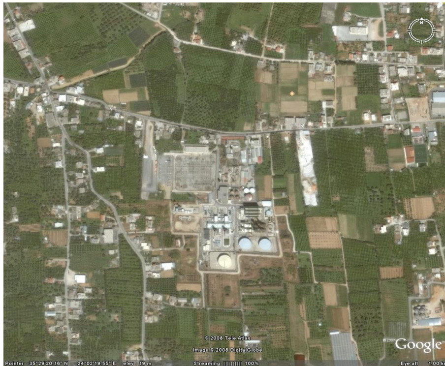
Σχήμα 1.2 Εικόνα του υποσταθμού ΔΕΗ Χανίων ( http://earth.google.com/ )
