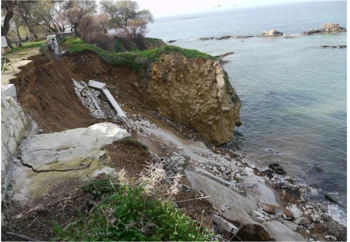
Φωτογραφία 1.2. Το αποτέλεσμα μετά την κατολίσθηση από τη δυτική πλευρά του μνημείου
