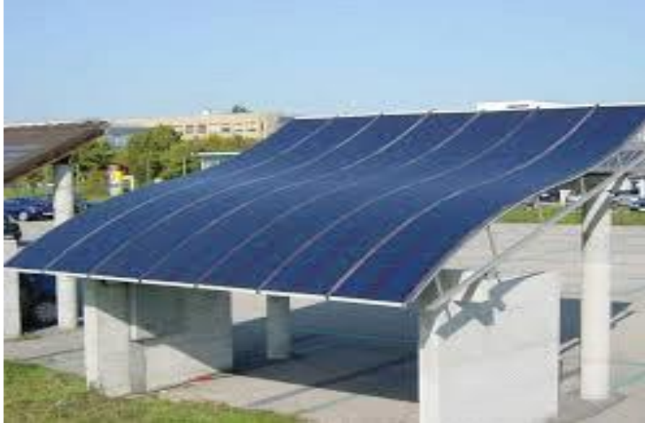
Εικόνα 5. φ/β πλαίσιο Άμορφου πυριτίου
