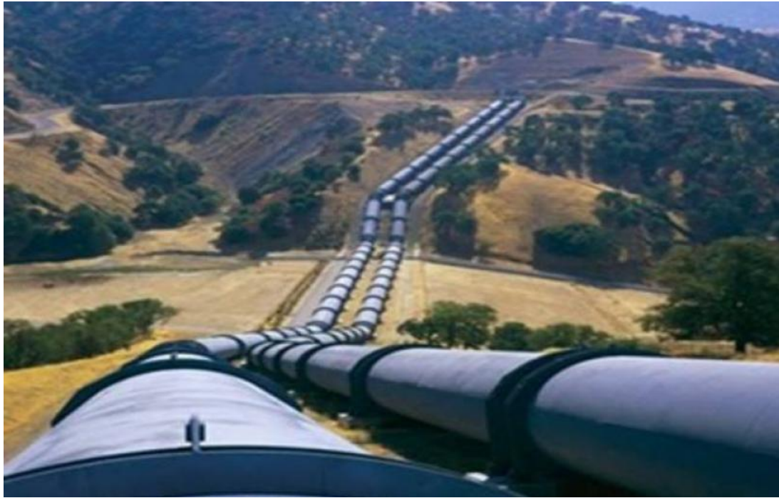
Εικόνα 3.11: Αγωγός μεταφοράς πετρελαίου
