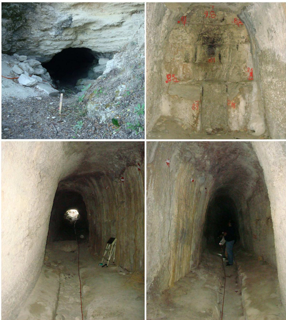
Σχήμα 4.2 Είσοδος της σήραγγας (πάνω αριστερά), το τέλος της (πάνω δεξιά), εσωτερική εικόνα με κατεύθυνση προς την είσοδο (κάτω αριστερά), εσωτερική εικόνα με κατεύθυνση προς το τέλος της σήραγγας (κάτω δεξιά).
