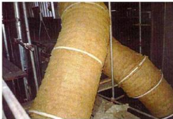
Σχήμα 20: Θερμομόνωση εγκαταστάσεων με χρήση ορυκτοβάμβακα
