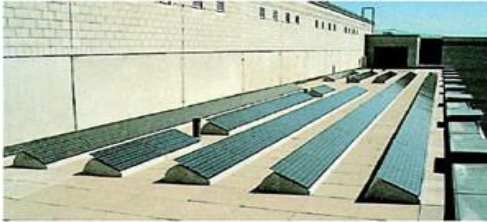
Σχήμα 30: Εφαρμογή φωτοβολταϊκών σε ταράτσα βιομηχανικού κτιρίου
