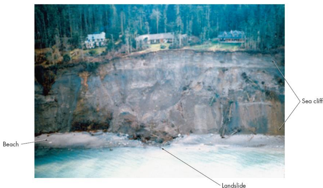
ΣΧΗΜΑ 1.18 ΕΝΑ ΕΠΙΚΙΝΔΥΝΟ ΔΩΜΑΤΙΟ ΜΕ ΘΕΑ Αυτά τα σπίτια που βρίσκονταν σε ένα λόφο της Ουάσινγκτον παρασύρθηκαν από αυτήν την κατολισθήση του 1997. Επιπρόσθετες κατολισθήσεις στο
