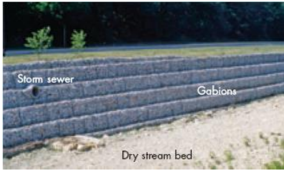
ΣΧΗΜΑ 2.27 ΣΑΚΟΙ ΜΕ ΠΕΤΡΕΣ ΣΤΑΘΕΡΟΠΟΙΟΥΝ ΤΗΝ ΟΧΘΗ ΕΝΟΣ ΡΕΥΜΑΤΟΣ Αυτοί οι σάκοι κατά μήκος της ξεραμένης κοίτης του ρεύματος Shoal Creek στο Austin του Texas, είναι στοιβαγμένα καλάθια από μεταλλικό δίκτυ γεμισμένο με πέτρες. Τοποθετήθηκαν για να προστατεύουν το ρεύμα από τη διάβρωση. Η πορώδη τους φύση επιτρέπει σε κάποιο από το νερό να διαρρέυσει, ελαττώνοντας την εξάπλωση της πλημμύρας. (Robert H. Blodgett)
