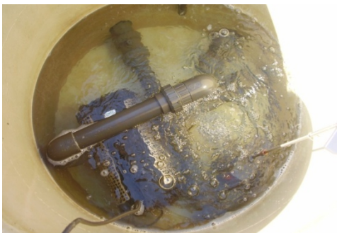
Εικόνα 18 Υποβρύχιο αντλιοστάσιο (24)
