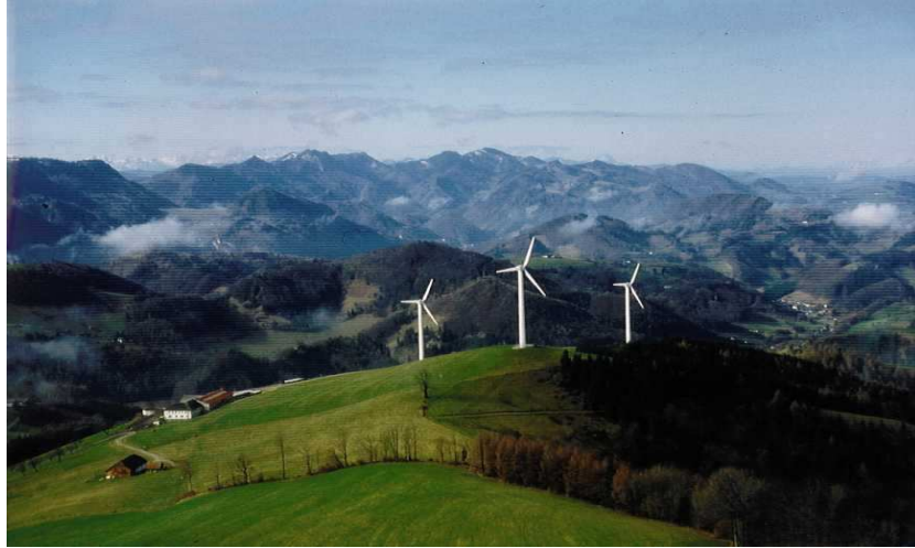
Εικόνα 2.9 ανεμογεννήτριες τοποθετημένες πάνω σε λόφο
