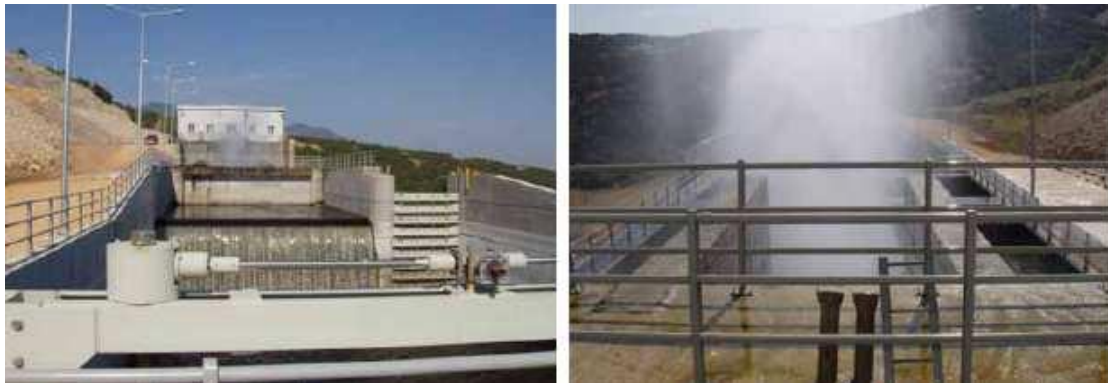
Σχήμα 12: Άνω έργο καταστροφής ενέργειας
