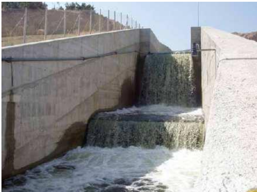
Σχήμα 13: Κάτω έργο καταστροφής ενέργειας
