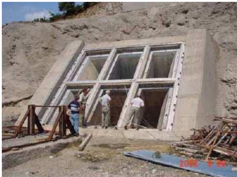
Σχήμα 10: Σήραγγα εκτροπής και ο εκκενωτής πυθμένα
