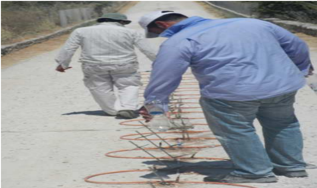
Η τοποθέτηση των ηλεκτροδίων κατά μήκος του δρόμου
