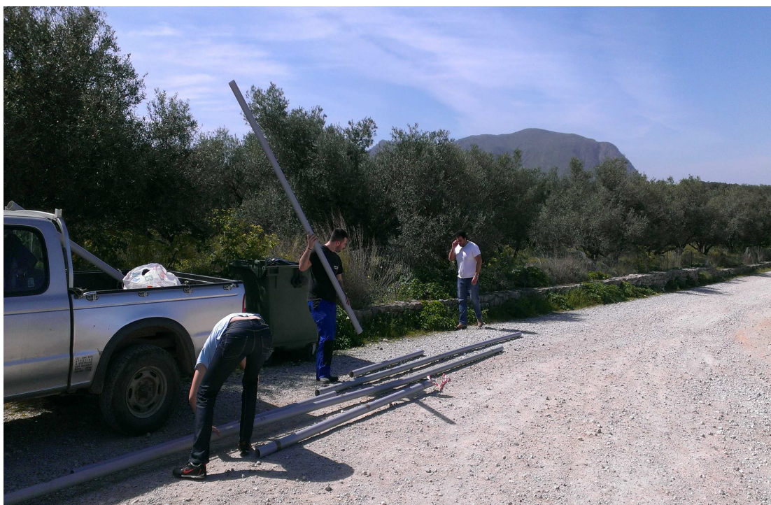
Σχημα7.21 . Έναρξη κατασκευής ενιαίου βρόγχου 10 x 5 μέτρα
