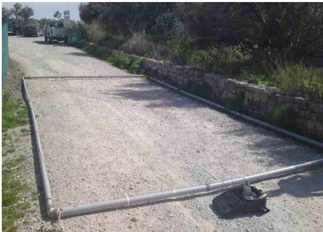
Σχημα7.24 . Ολοκλήρωση της κατασκευής του βρόγχου
